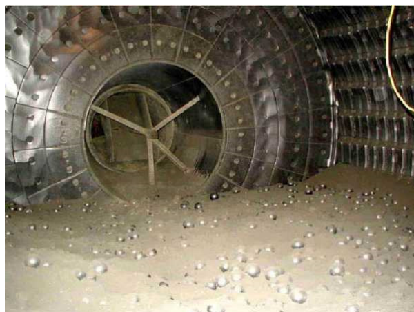
Slika 2 Unutrašnjost mlina s kuglama za mljevenje klinkera
