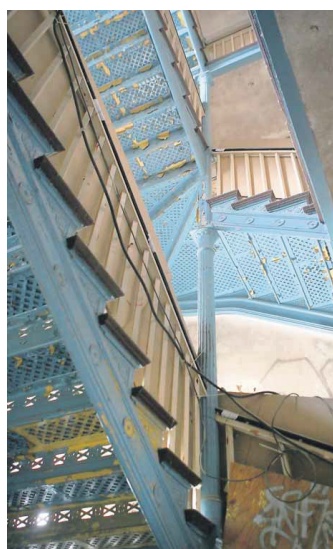
Einblick. In die zwei historischen Treppenhäuser werden Lifte eingebaut. Fotos (3): Klaer
