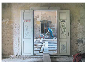
Durchblick. Die Zimmerflucht durch sieben Räume in der Beletage bleibt erhalten.
