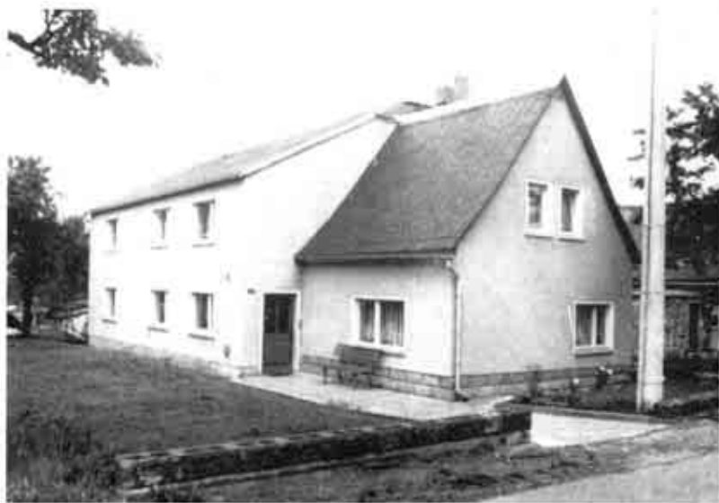
34 Ehemaliges Umgebäudehaus Schönbach Nr. 299 („Neudorf“). Dieses Haus sah vor dem Umbau ganz genauso aus wie Nr. 300. Die bauliche Besonderheit, daß zwei Häuser sich wie Zwillinge glüchen, ist nun nur noch auf Fotos beweisbar. Der Umbau ist gestalterisch nicht gelöst.
