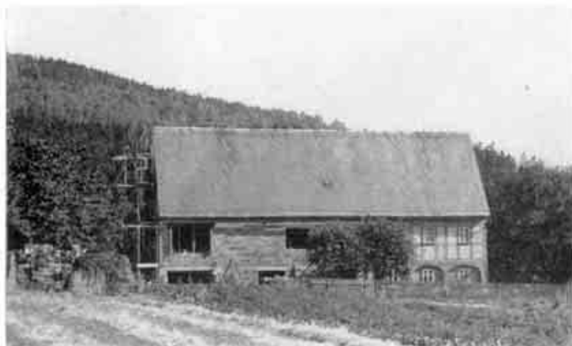
24 Schwerwiegender Eingriff in ein Umgebäudehaus. Während der Umgebündeteil noch steht, wird völlig willkürlich der Restteil in Art eines Neubausiedlungshauses umgestaltet. Damit wird wieder ein Stück bodenständiger Bauweise völlig entwertet – Hörnitz, Kreis Zittau.
