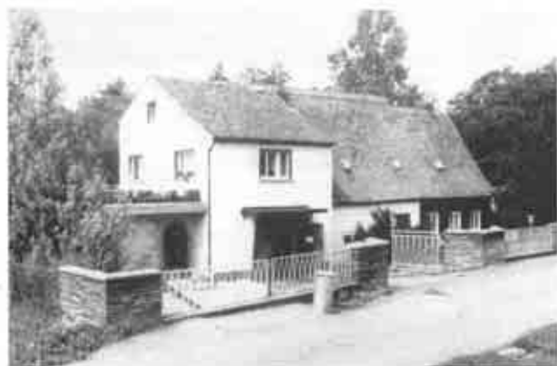
27 Viel ist nicht gleichzeitig gut. Dieses Beispiel aus Kottmarsdorf, Kreis Löbau, zeigt, wie häßlich die Häufung von Modernismen ist, und es beweist, daß proportionslose Anbauten ein Haus überwuchern können.
