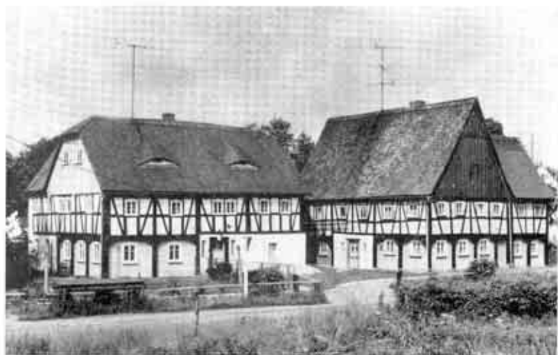
1 Häusergruppe in Oberseifersdorf, Kreis Zittau. Am linken Haus ein gutes Beispiel der Kopplung von Fenstern zur Erhöhung des Lichteinfallcs.
