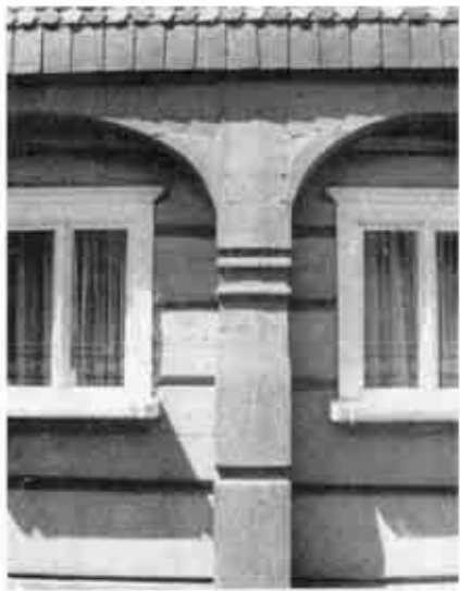
14 Umgebinderstützen wurden sehr oft mehr oder weniger stark profiliert und damit verziert – Obercunnersdorf, Kreis Löbau, Nr. 304.
