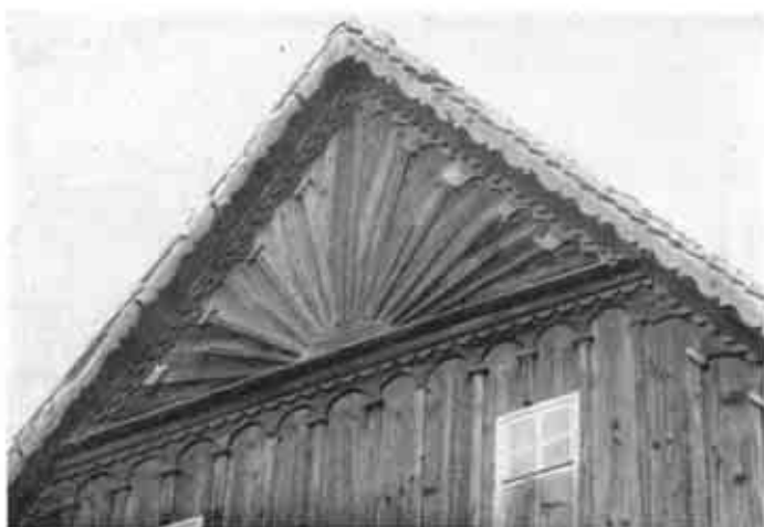
9 Verbreiterungssonne und Verleistungsverzierungen sowie Zierbretter einer Giebelspitze — Eibau, Kreis Löbau, Hauptstraße 197.
