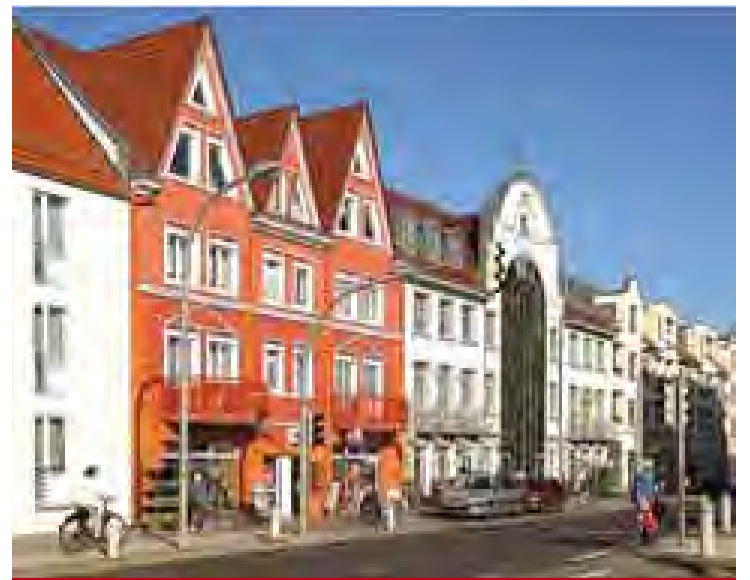
Demmin - Ein wichtiges Ziel ist die Sanierung der wenigen erhaltenen Gebäude
