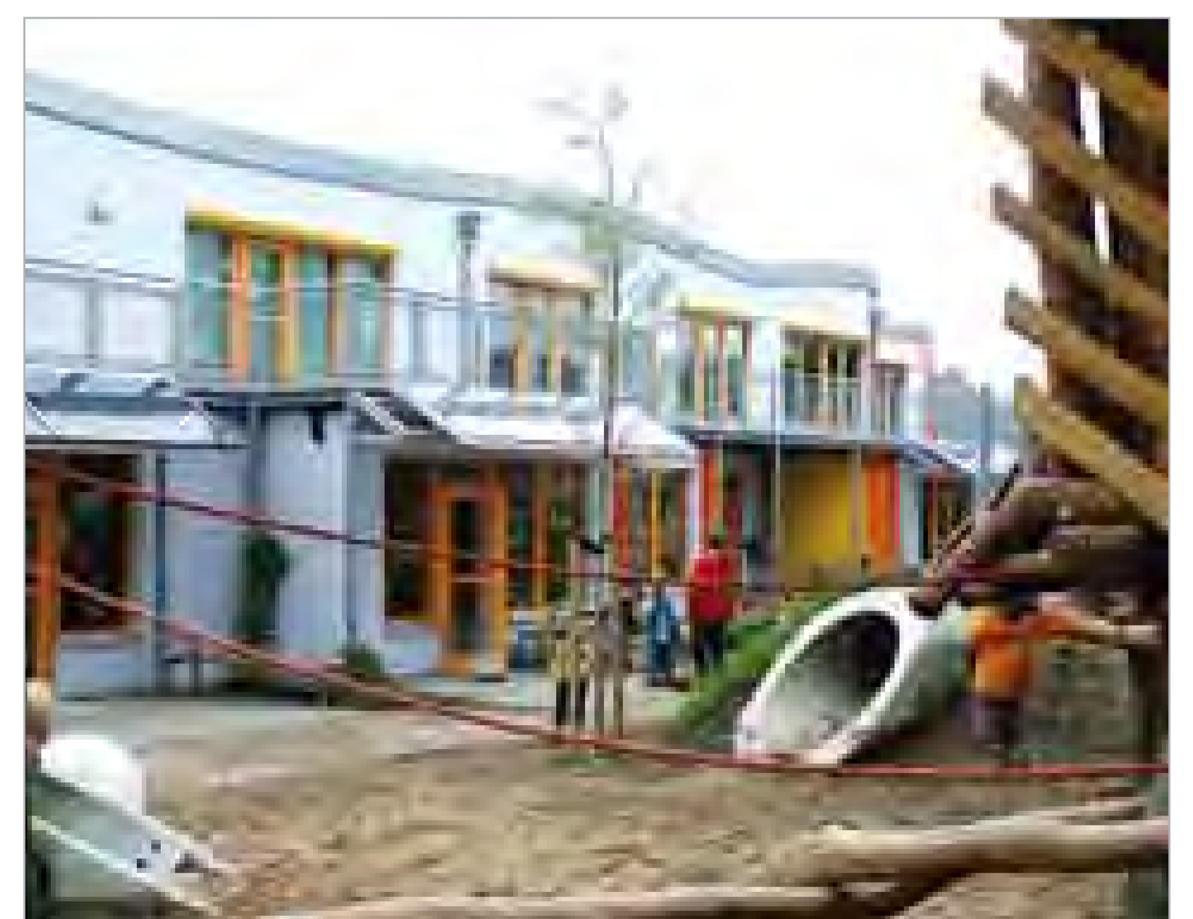
Grevesmühlen - Der Hort steht für umweltbewusstes und nachhaltiges Bauen
