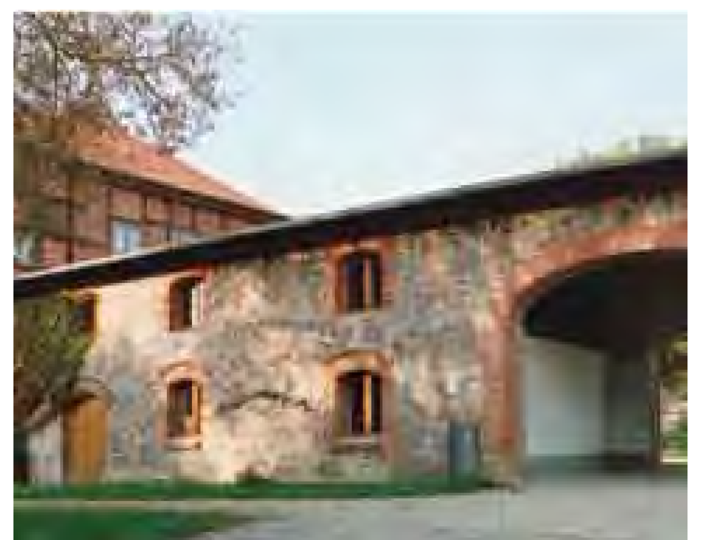
Nebengebäude - Die Kombination aus Feld- und Backsteinen ist einzigartig
