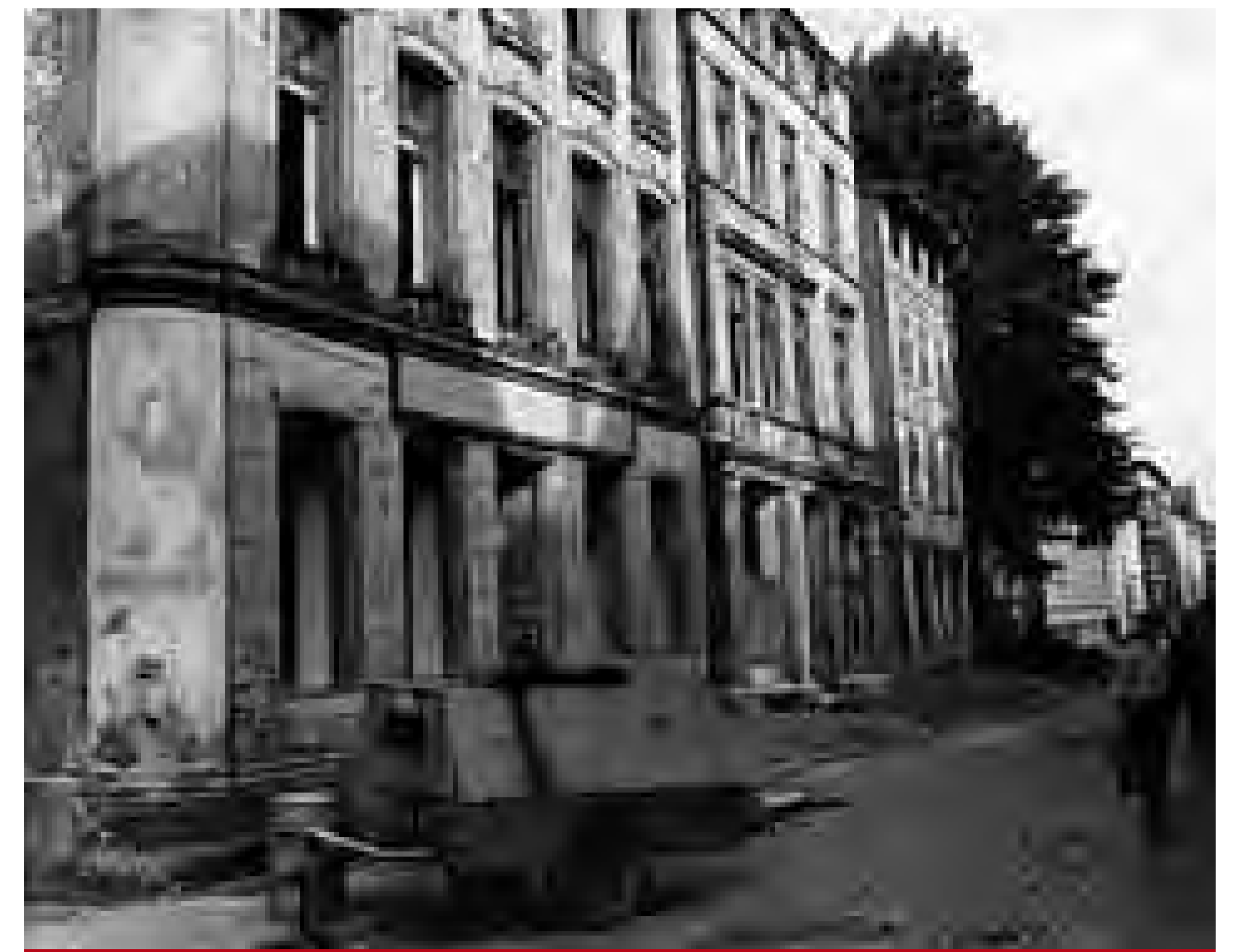
Puschkinstraße - Die drei historischen Häuser wurden 1988 gesprengt
