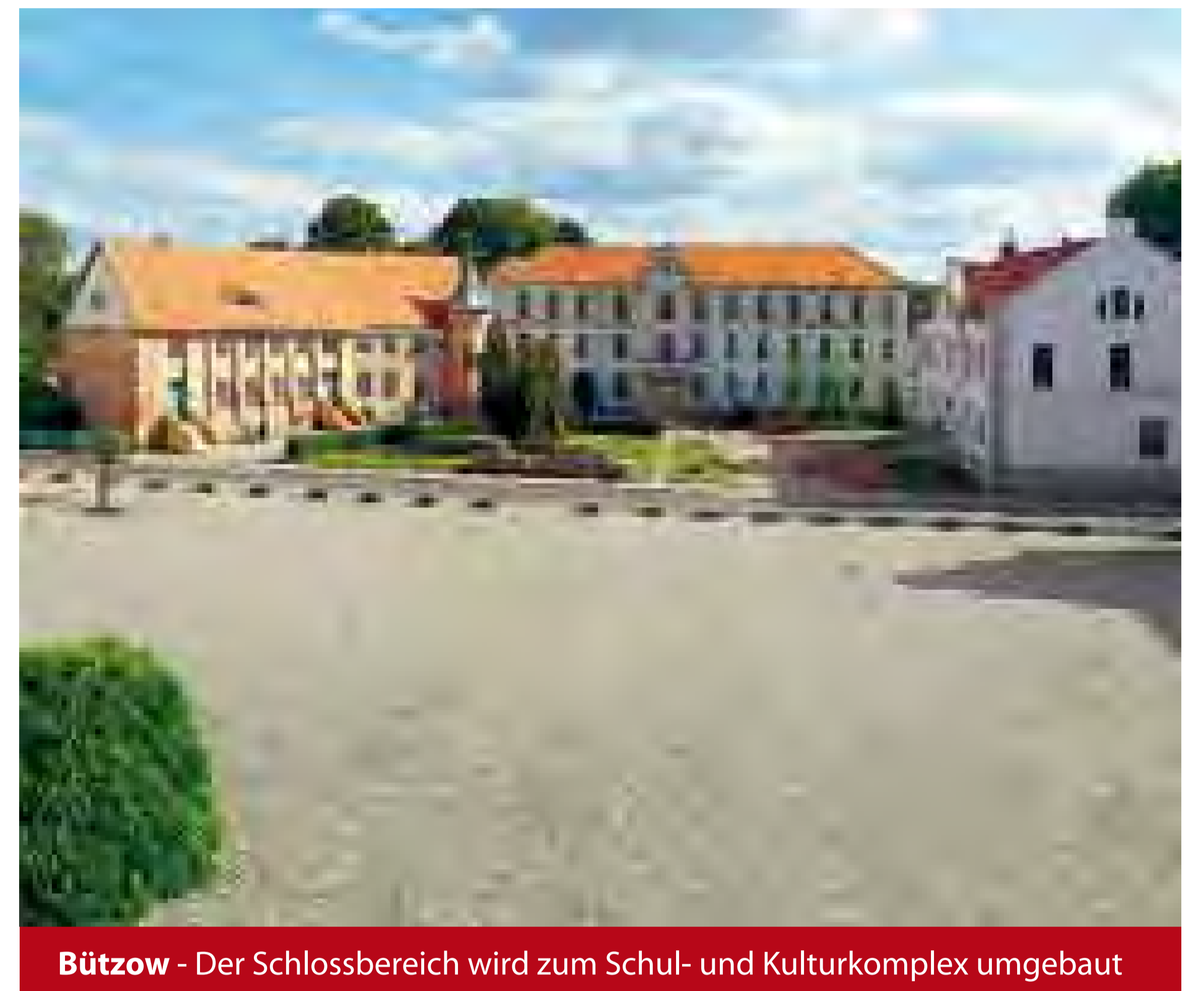
Bützow - Der Schlossbereich wird zum Schul- und Kulturkomplex umgebaut
