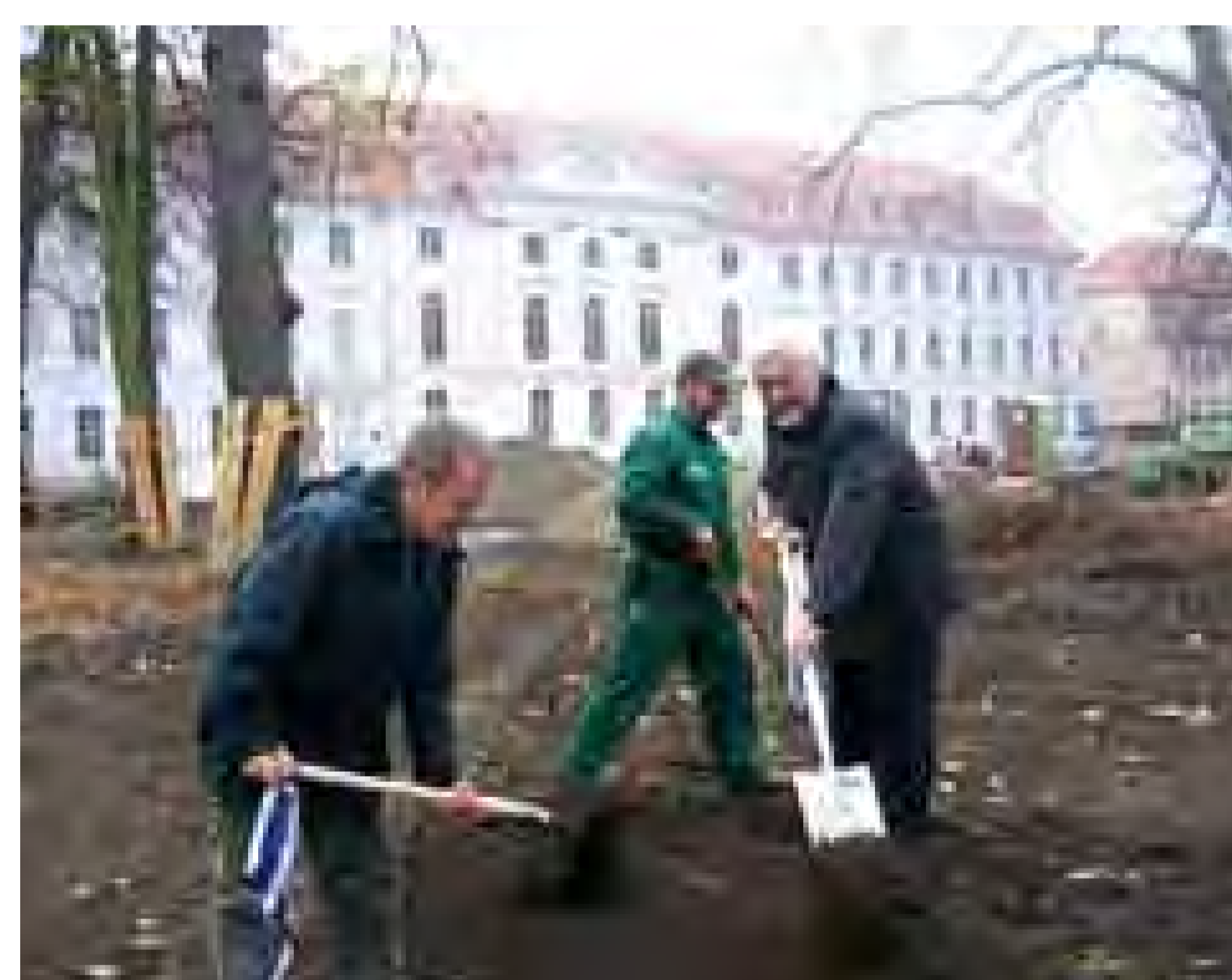
Greifswald - Erster Spatenstich für die Umgestaltung des wichtigen Platzes
