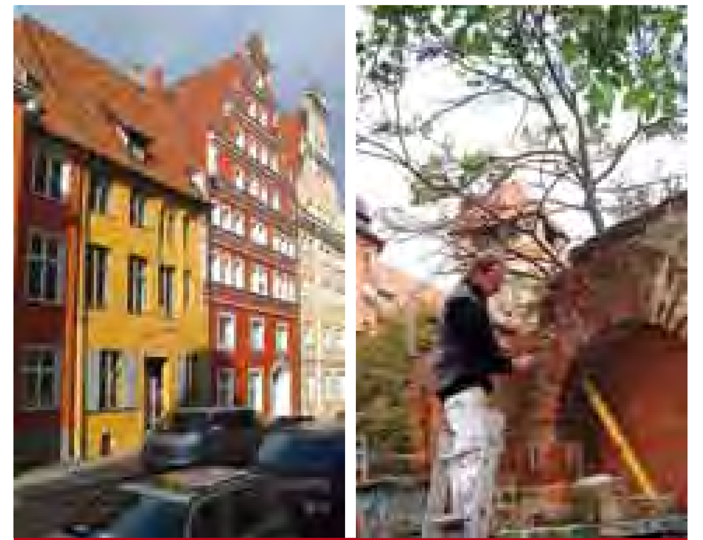
Fährstraße und Stadtmauer - Viele Bereiche erstrahlen bereits im alten Glanz
