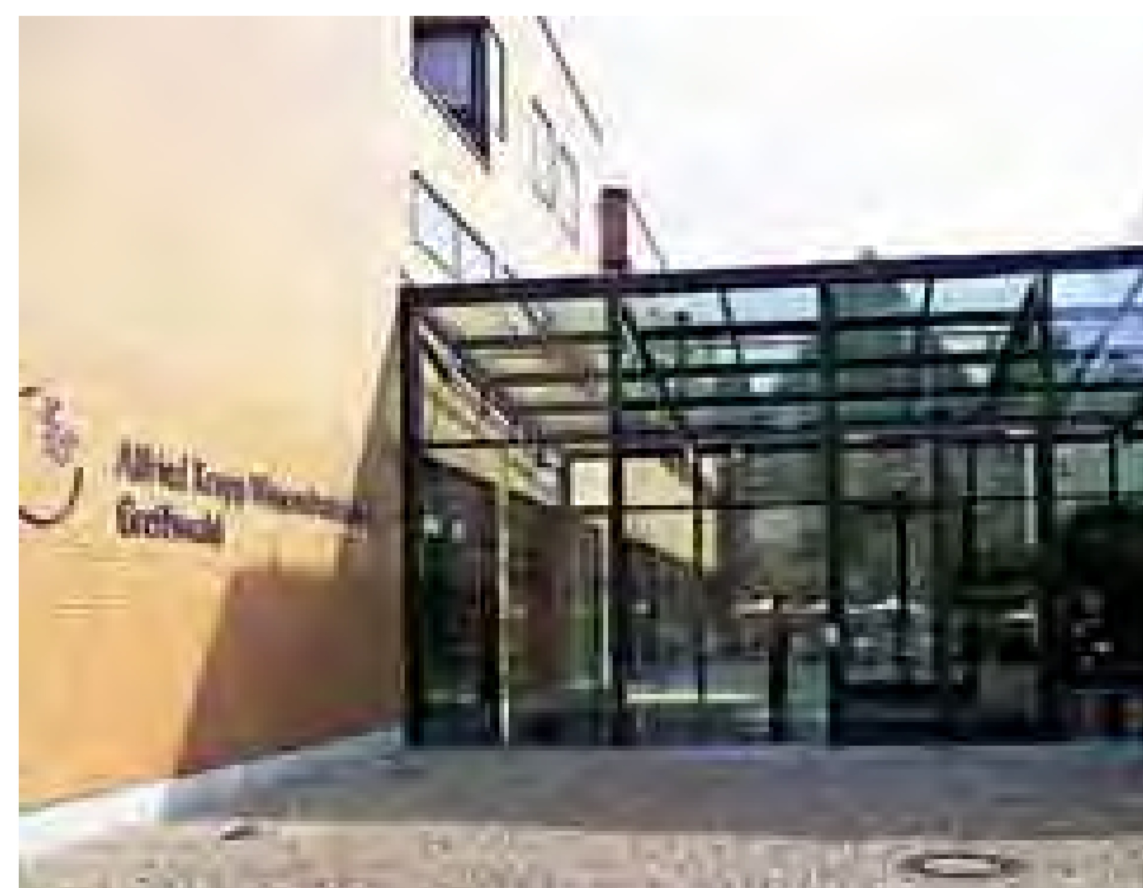
Greifswald - Der Komplex besteht aus zwei Neubauten und einem Altbau
