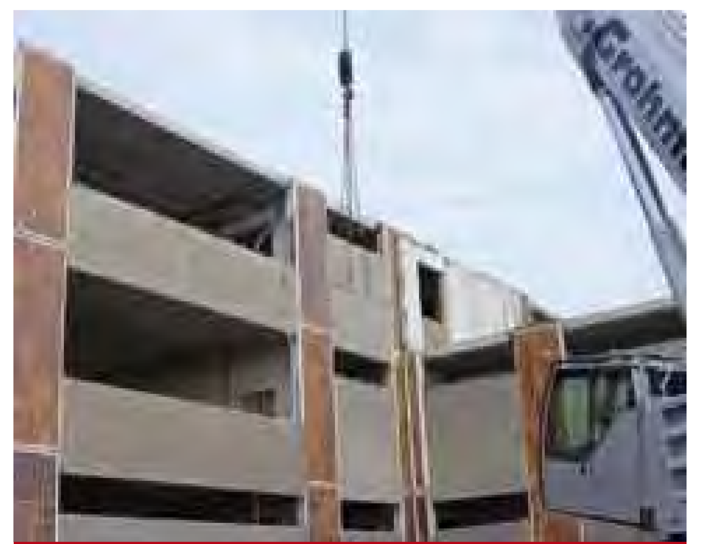
Rückbau - Dauerhaft leer stehender Wohnraum wird zurückgebaut
