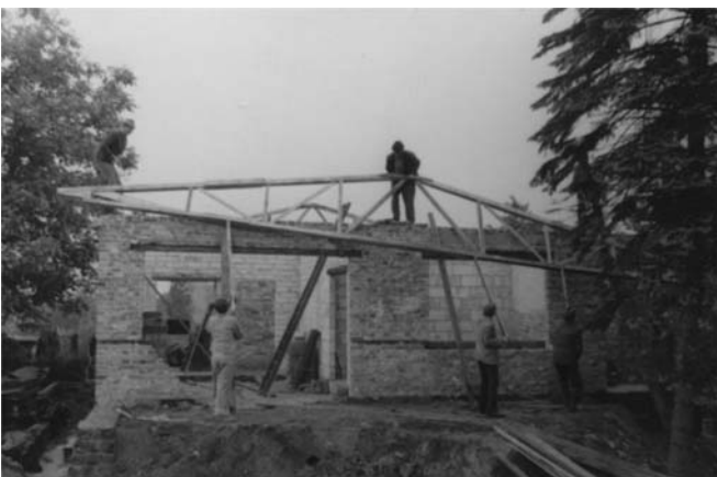
Die Zimmerer waren echte Profis. Zum erstenmal seit Beginn des Bauens konnte der Bau- herr sich zurücklehnen und dem Ablauf einer Montage interessiert zusehen.
