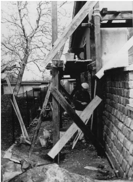
Sieht aus wie der Abriss eines Holz-Schuppen, ist aber eine „schwere Maurerrüstung“. Zumindest wurden darauf entsprechende Arbeiten Verrichtet.
