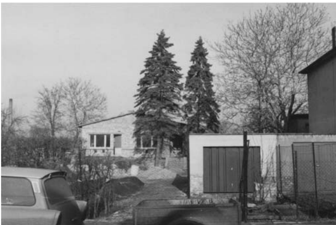
Oktober 1971 – der Bau ist winterfest
