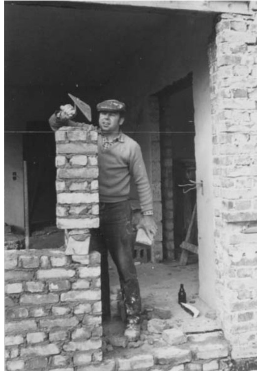
Multitalent Werner zeigt, was ein guter Maurer kann. Dieser Pfeiler steht seit dreißig Jahren zwischen Fenster und Terrassentür.
