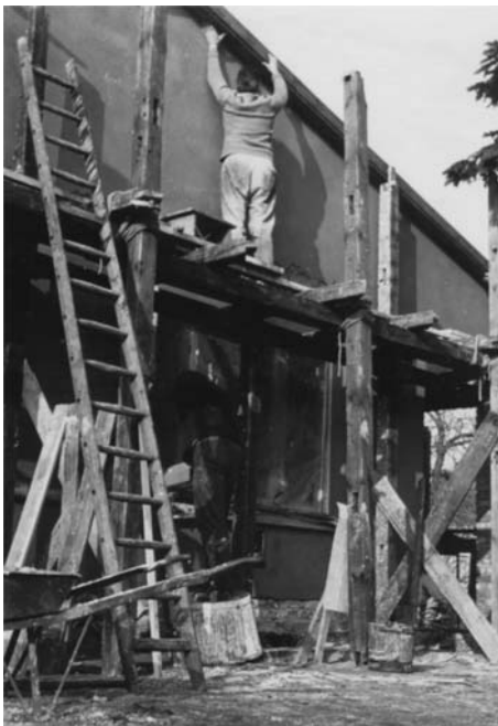
Die letzten Handschläge am Außenputz. Das Haus hat nun eine schmutzig grau-Grüne Fassade. Reichlich Zement im Mörtel tat seine Wirkung. Passanten stehen kopfschüttelnd vor dem Grundstück, und wir schämen uns ein Wenig mit.
