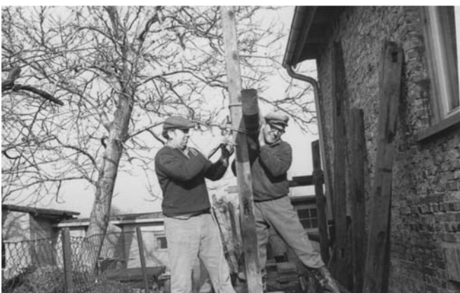
Gerüstbau aus schweren Kanthölzern. Werner baut, der Bauherr (rechts) trägt die Last. Der Streichbaum auf seiner Schulter ist 7 Meter lang. So entstand die „große“ Fliegerrüstung
