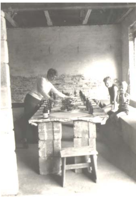
Aber was ist das schon? Noch immer gibt es keinen Schutz gegen Regen. Das ist nach Meinung des Bauherren kein Grund zum Feiern. Er spricht von einem „Dach-zu-Fest“ Kein besonders schöner Anblick. Das Mauerwerk aus geputzten Altziegeln sieht schlimm aus. Aber das Dach wird geschlossen! Die sicher 100 Jahre alten Bretter aus Pitch-Pine kommen noch einmal zu Ehren.
