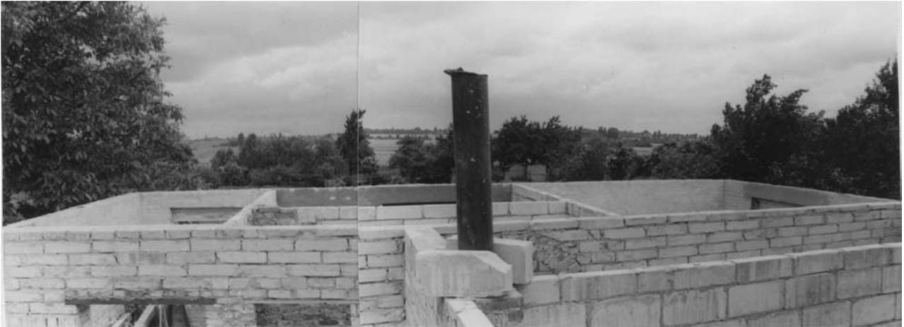
Die Wände sind fertig. Im Hintergrund von links nach rechts: Küche, Bad mit Korridor davor, Schlafzimmer. Man beachte der provisorischen Schornstein. Im Keller konnte schon geheizt werden.
