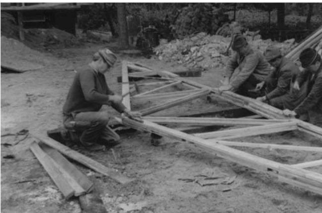
Wenn vier Mann gleich-zeitig nageln, dann klingt das wie das Trommeln eines Spechts. Nach erstaunlich kurzer Vorbereitungszeit konnte mit dem Richten begonnen werden
