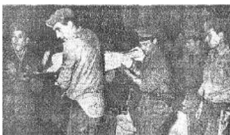
I vigili del fuoco all'opera per recuperare le vittime del crollo
