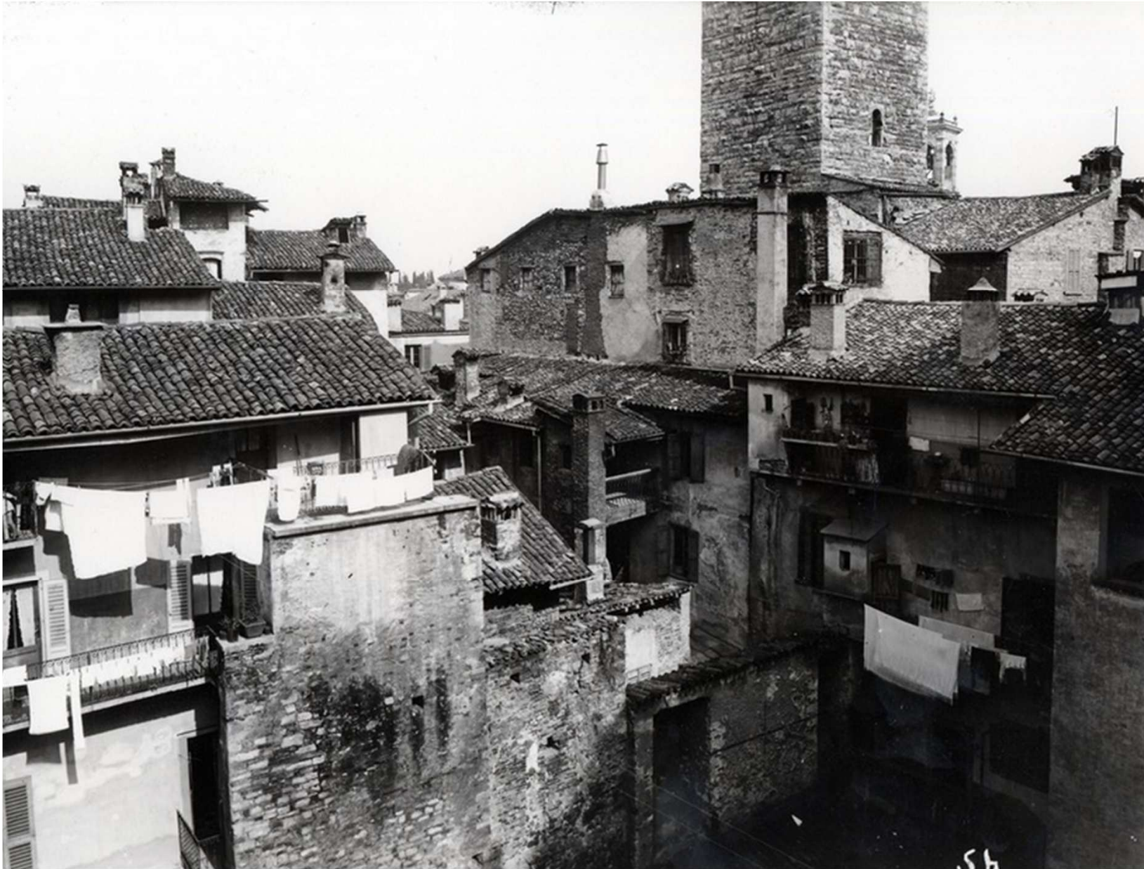
Scorcio su una fatiscente Bergamo alta nel 1934, precedente all'attuazione del piano di risanamento redatto su progetto di Luigi Angelini e divenuto attuativo nel 1937.
