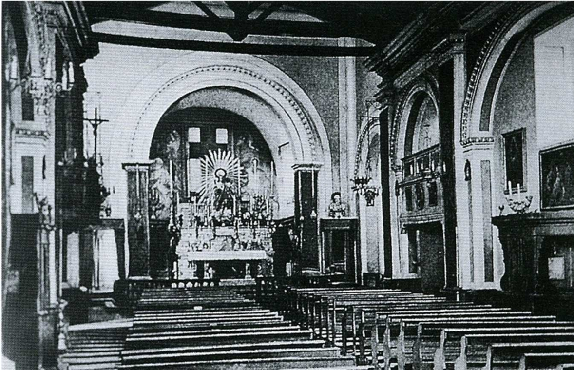
Vista interna della chiesa prima del bombardamento.
