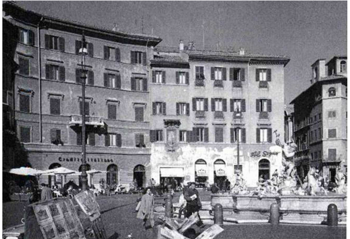
Veduta dell'emiciclo Nord di piazza Navona, con i prospetti ripristinati
