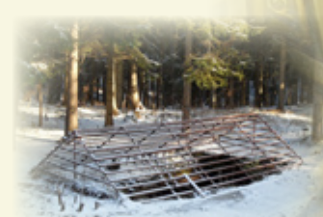
Eingang zum Stollen Louis, 19. Jh.
