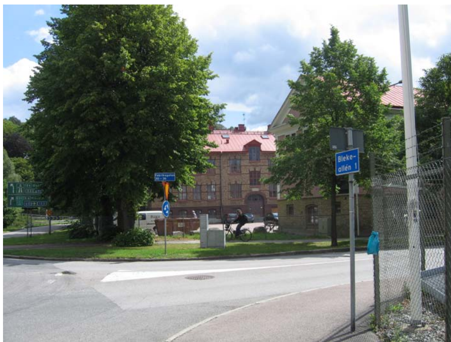
Gårdaskolan från väster och Fabriksgatan
