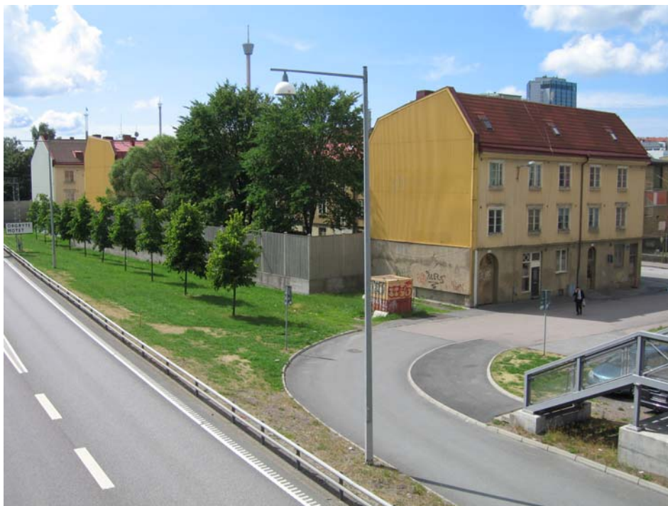
Bebyggelsen vid Fabriksgatan, kv Cedern, från nordost och E6/E20
