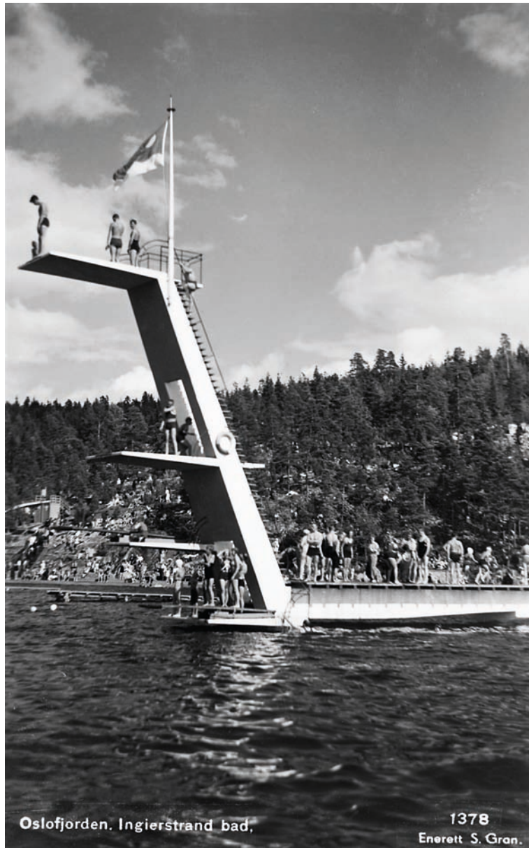
Den første delen av Ingierstrand Bad sto ferdig i 1932 og var et topp moderne badested med restaurantbygning, dansebane, parkeringsplasser, kai, fortøyningsanlegg for fritidsbåter, dusj- og toalettanlegg, kiosk, stupetårn og rutsjebane. Alt i funksjonalisme.
