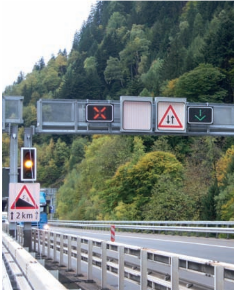
Montage, Inbetriebnahme und Tests in nur vier Wochen Mounting, commissioning and tests in just four weeks
