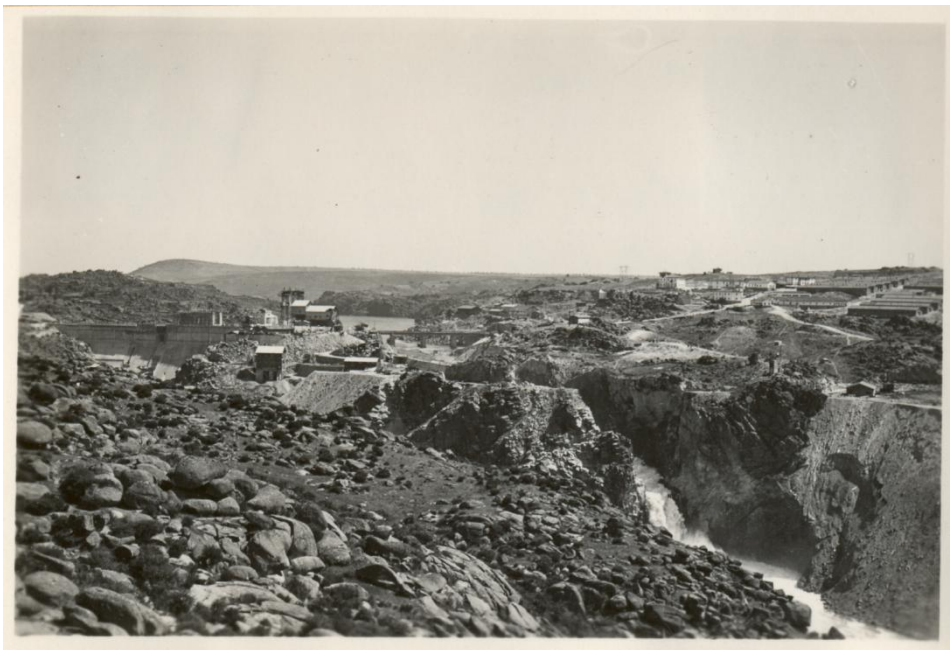
Figura 7: La presa, el poblado y el aliviadero, 1934. Fuente: Rappert, viaje de Th. Rehbock
