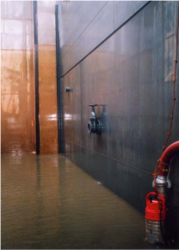
Schotten met een afsluiter bij drooggezet Naviduct.
