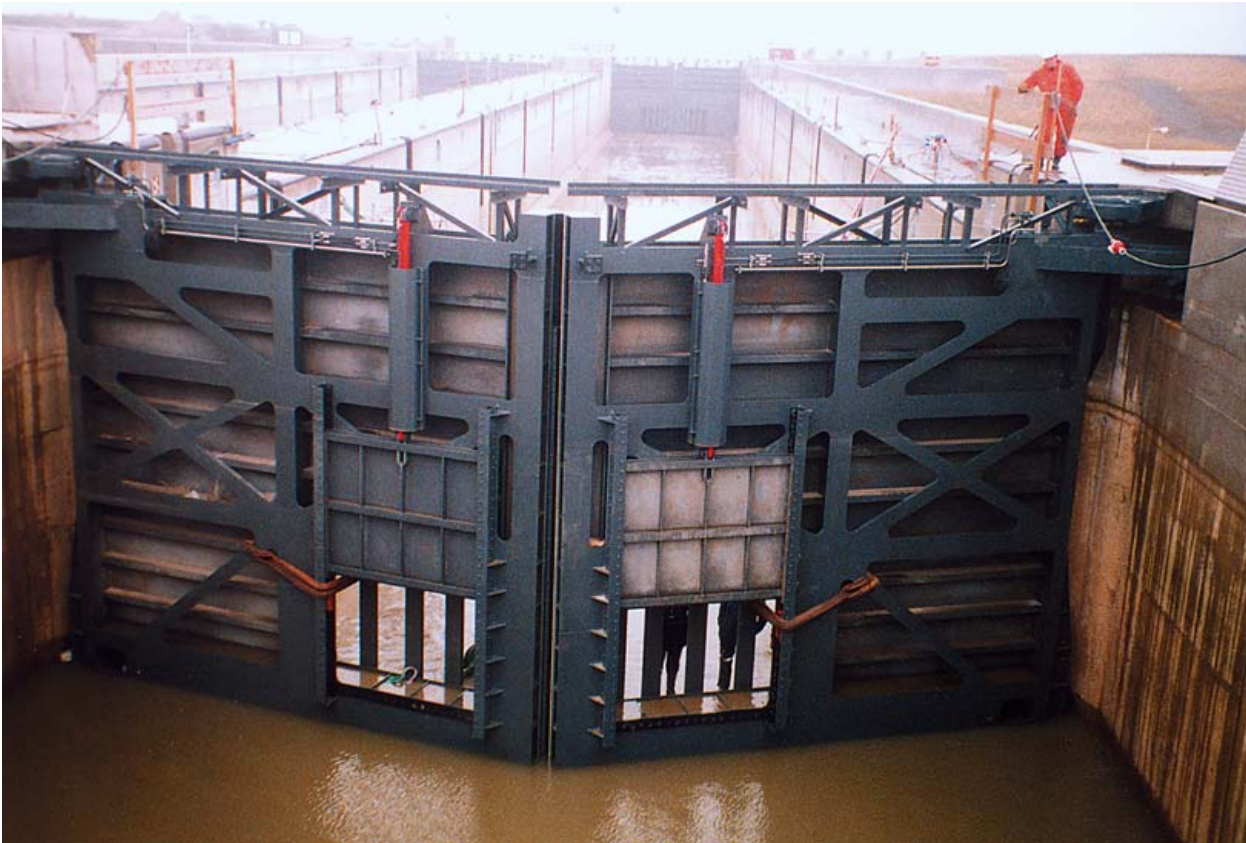
Naviduct drooggezet, metingen aan sluisdeuren.
