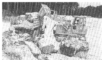
gewaltige Erdbewegungen beim Bau der NÖFV- Sportschule
