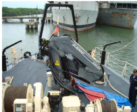
Montaje de grúa en la popa de la embarcación
