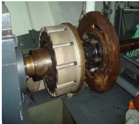
Instalación del acople flexible.
