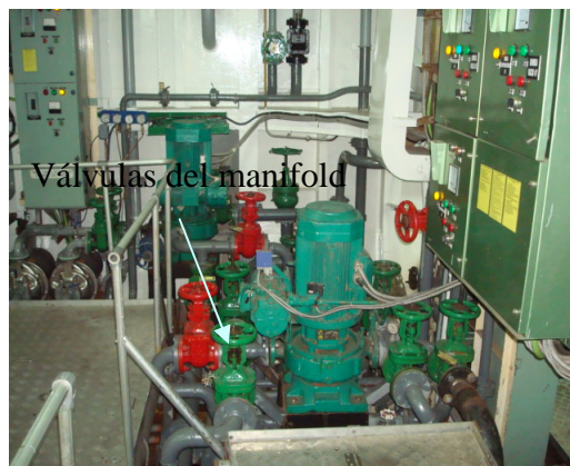
Montaje de bombas en sala de máquinas.
