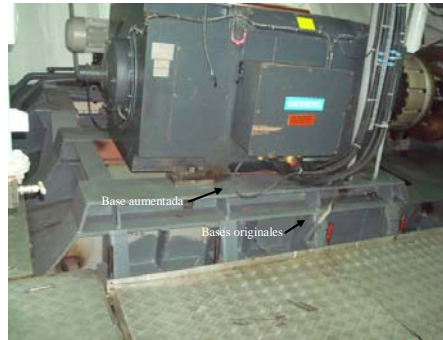
Instalación de moto propulsores
