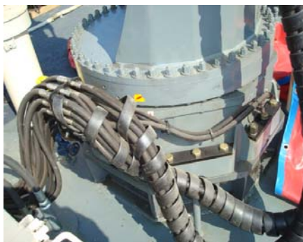
Base de la grúa montada en cubierta de popa del buque.
