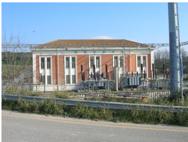
Figura 42: il fabbricato della SSE di Fara Sabina
