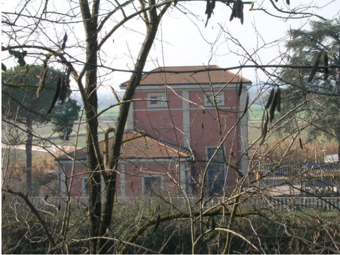
Figura 43: il fabbricato gru della SSE di Fara Sabina
