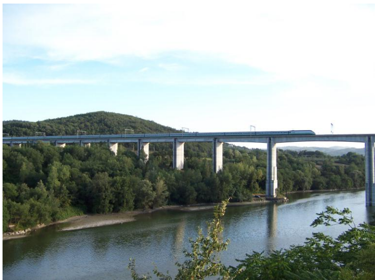
Figura 28: un viadotto della linea nei pressi di Arezzo
