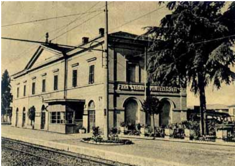
Figura 35: la stazione di Fara Sabina dopo l'avvenuta elettrificazione della linea Roma - Orte
