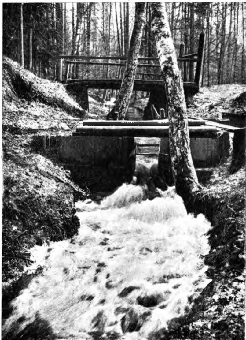
Водослив для учета внешнего стока с бассейна р. Жабенки в Лесной опытной даче. Кв. 3, уч. 1 (1909)
