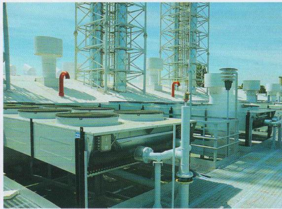
С Пластинчатые теплообменники охлаждения рубашки двигателя и масла
