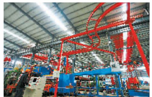
7月26日,位于沁阳市沁北工业区的广东兴发铝业(河南)有限公司10万吨高档铝型材深加工项目工地,工人们正在调试设备。该项目总投资10亿元,投产年后产值可达20亿元。⑤2 本报记者 史长来 摄
