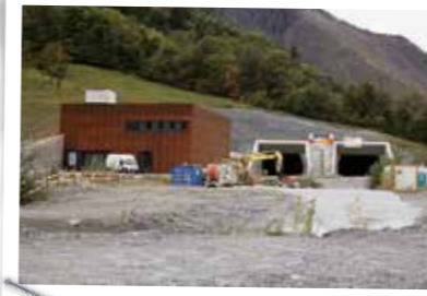
Tunnel Eyholz, Portal Grosshüs in der Endgestaltung. Die Arbeiten zum Anschluss an das bestehende Autobahnstück haben begonnen.
