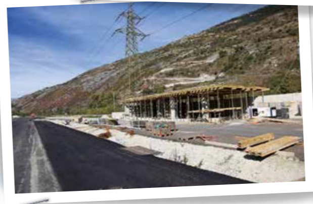
Bild oben: Belagsarbeiten auf der Strecke Turtmann-Gampel.
