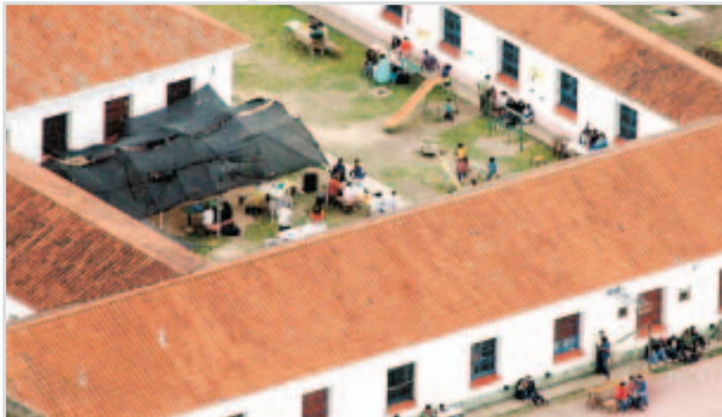
Desde arriba. La Unidad Penitenciaria n° 28, en una captura aérea realizada por Trama Urbana
