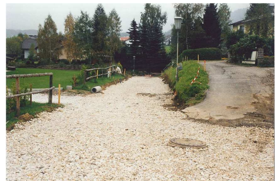
Sanierung St. Anna-Weg 1997
