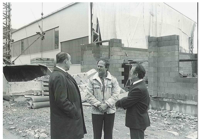
Fa. HA-GE Baustelle - 1987
