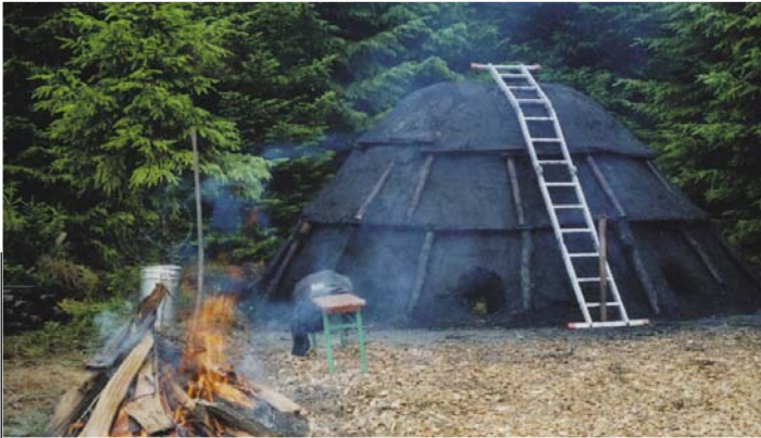
Der fertig mit Lösch abgedeckte Meiler, im Vordergrund wird die Holzkohle zum Zünden hergestellt.
