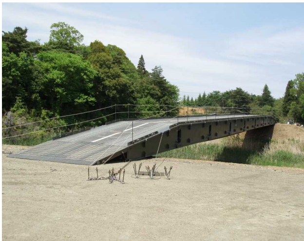
新架橋（架設された橋体）
