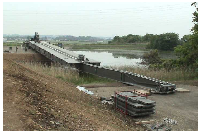
作業性能試験（橋体が繰り出される新架橋）
