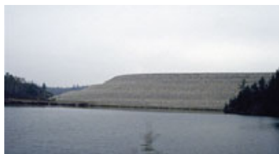
Uraanikaivoksen jätekipukasoja veden äärellä Elliot-järven kaivoksella Saskatchewanissa Kanadassa. Kivimurskasta vapautuva radon leviää kymmenien kilometrien alueelle. Tuuli levittää radioaktiivista pölyä ja hapan sadevesi liuottaa kasoista myrkyllisiä raskasmetalleja. Kuva: MiningWatch Canada.
