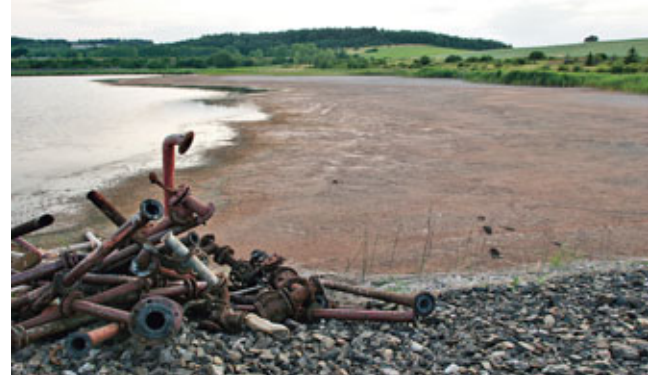
Pöybramin suljettu kaivos, Tsekin tasavalta. Uraanimalmin rikastuksessa syntynyt myrkyllinen lieju on pumpataan lietealtaaseen, jossa se on tarkoitettu pitää veden alla. Veden pinta on kuitenkin laskenut, jolloin tuuli pääsee levittämään radioaktiivista pölyä. Kuva: Greenpeace.
