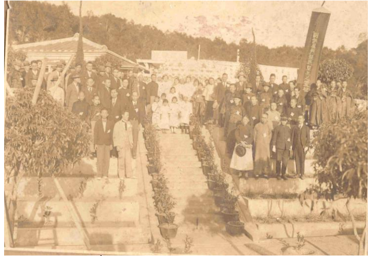
▲ 叢桂山房前景和門前的階梯花台
