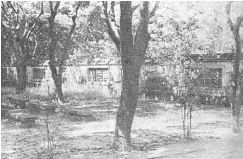
▶ ▲ 吳家花園內院牆為土鑿造 (牆上有釉花漏窗 (摘自 《臺灣文獻》29卷1期-名勝 古蹟調查,頁60))
