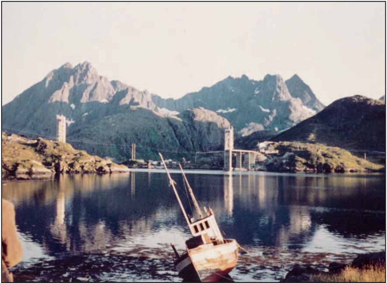
1961 — Kåkern bru under bygging.
