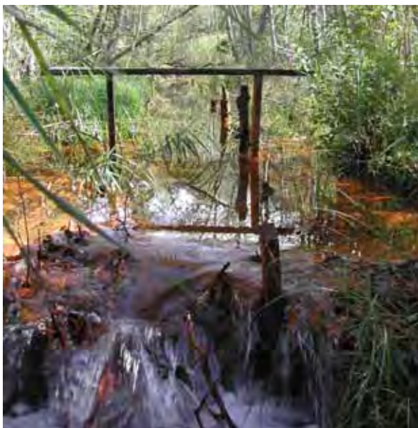
Bild 7. Det nuvarande överfallet i Gorränkällan är delvis skapat av en bäver.
