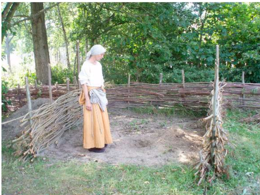
Fig. 2 En af Middelaldercentrets frivillige midt i Nålemagerværkstedet under opbygning. Fletvæggene er her færdige og ambolthullet er gravet.
