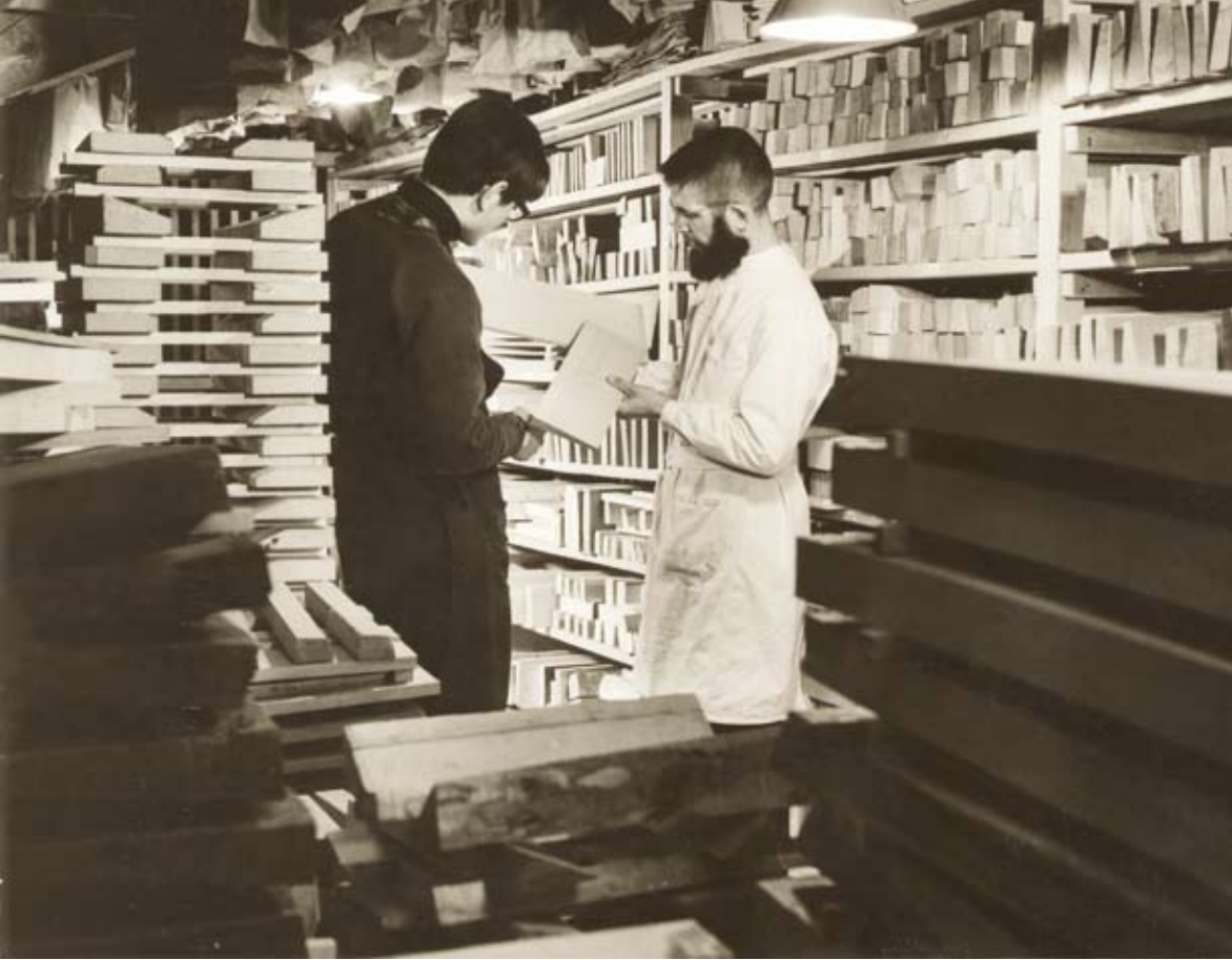
Frans van Dijk im Holzlager
