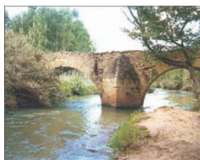
Puente de Issa
