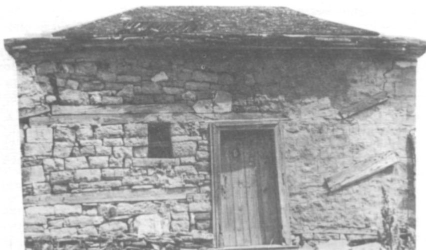
27. Ένα κατώϊ (υπόγειο), απ' τα δίπατα πλακοσκέπαστα σπίτια των Εζαρχαίων, χτισμένα το 1820, που αντέχει ακόμα στο χρόνο.
