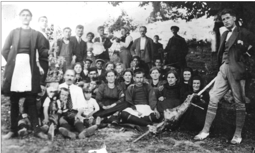
19. Γλέντι στον Κατιλανό (20-7-1932).
