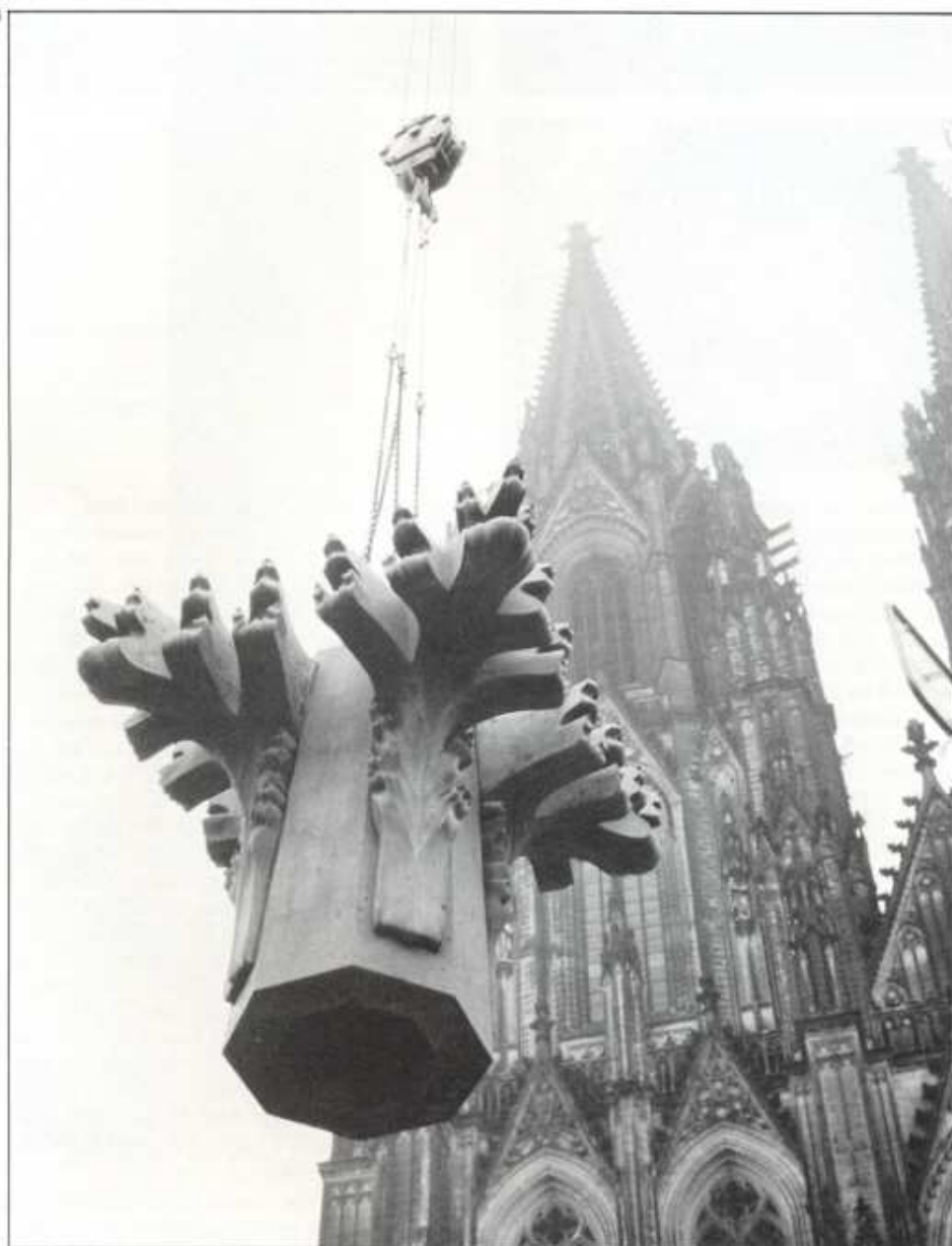
Bild 6: Die untere Mittelstütze mit den vier vormontierten großen Kreuzblumenauslegern schwebt über der Domplatte.
