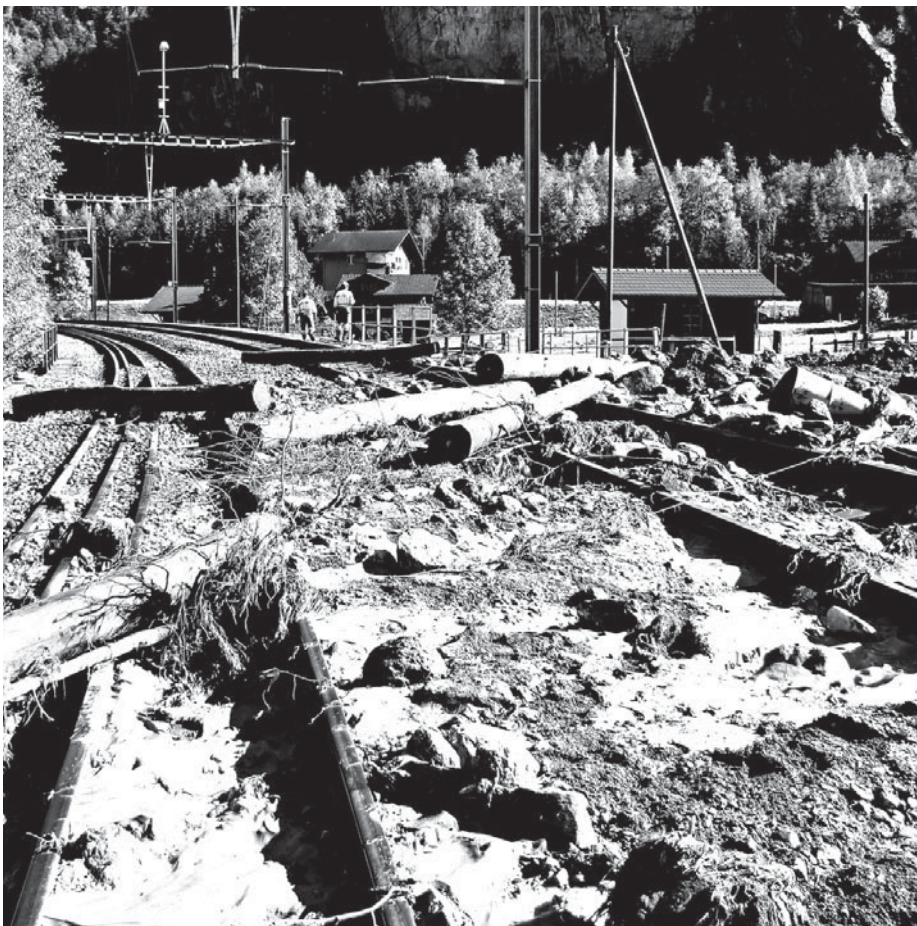
Einen Tag nach dem Unwetter im Kandertal begann die BLS mit dem Wiederaufbau der zerstörten Bahnanlagen und organisierte Ersatzlösungen für Personen- und Güterverkehr.
