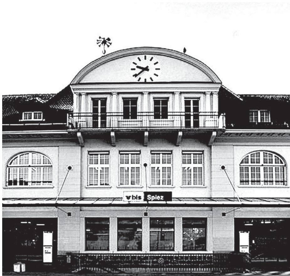
Der renovierte Bahnhof Spiez ist seit Ende 2011 barrierefrei und bietet Reisenden und Passanten attraktive Dienstleistungen.
