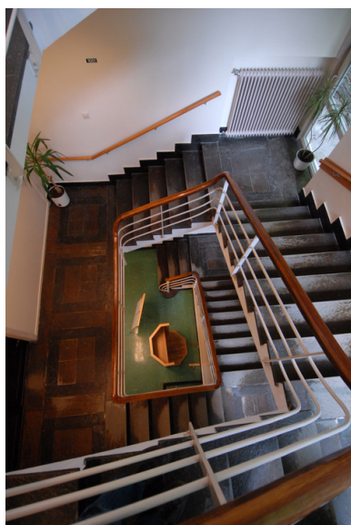
Trapp har heller i mønster. Foto: Leif Anker, Forsvarsbygg.
