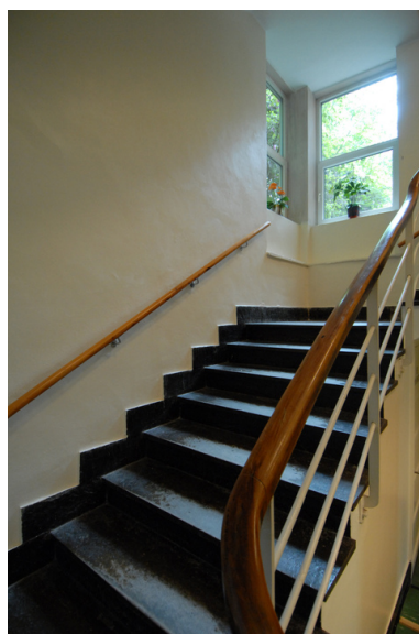
Vindusnisjer mot sør i trapp. Foto: Leif Anker, Forsvarsbygg.
