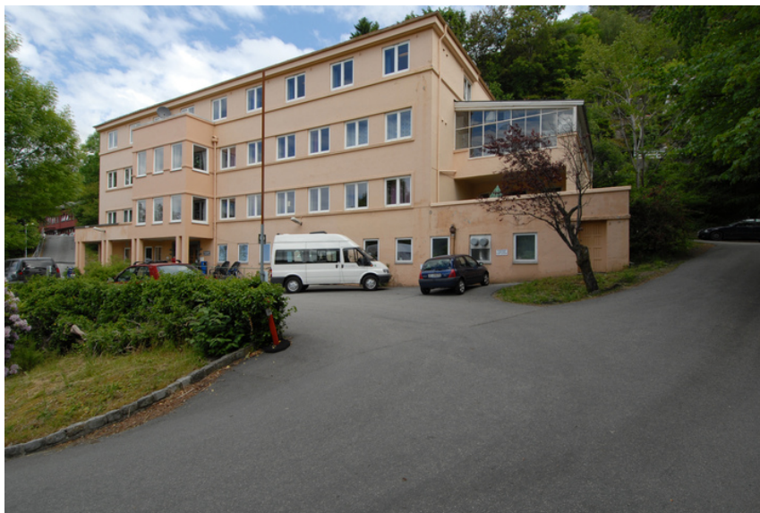
Hovedfasaden er vestvendt. Foto: Leif Anker, Forsvarsbygg.
