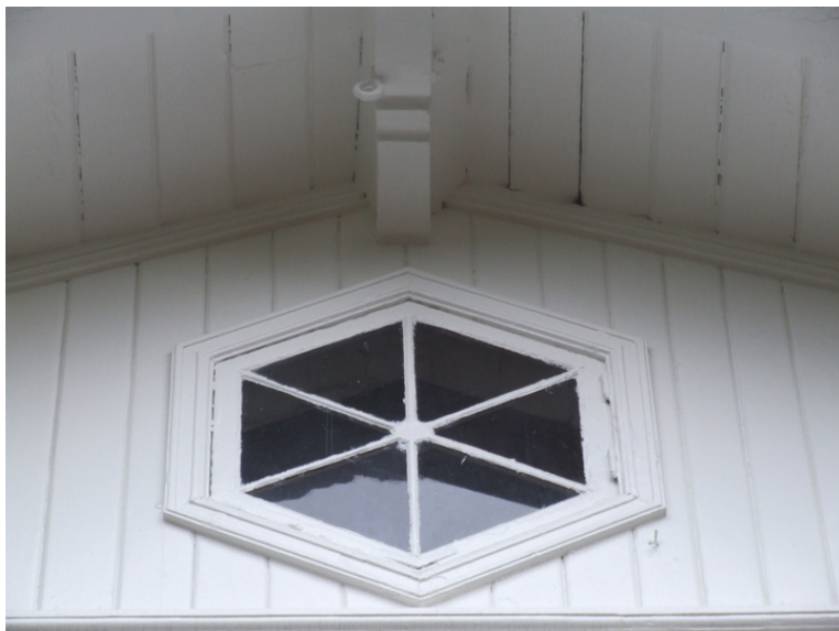
Gavlindu mot vest. Foto: Leif Anker, Forsvarsbygg.
