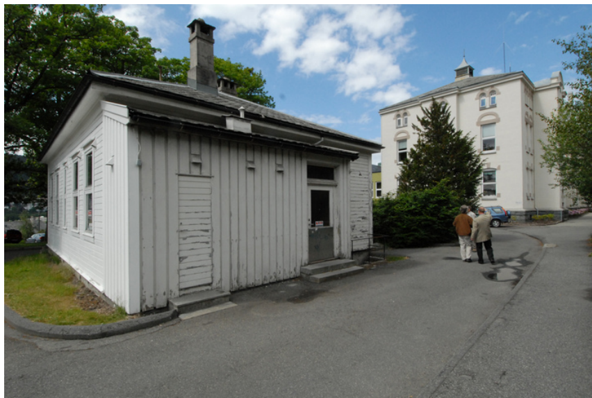
H-bygget fra vest. Foto: Leif Anker, Forsvarsbygg.
