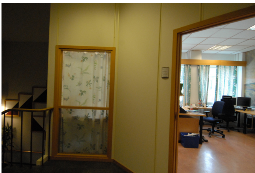
Trappehus er bygget om til kontor. Freskomaleri t.v. Foto: Leif Anker, Forsvarsbygg.
