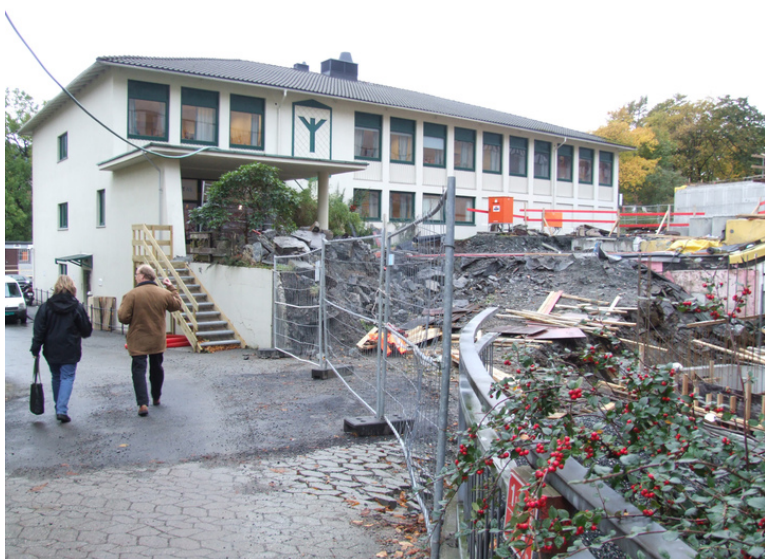
Fasade øst med hovedinngang. Foto: Leif Anker, Forsvarsbygg.
