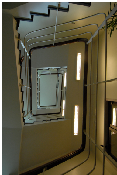
Trappehus mot loft. Foto: Leif Anker, Forsvarsbygg.
