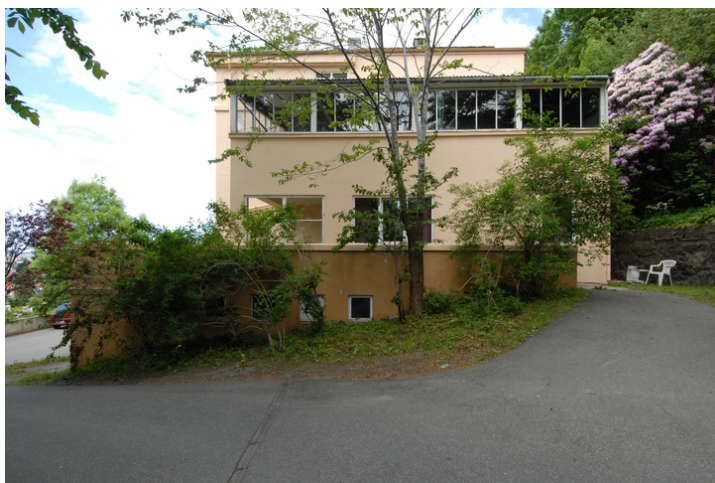
Fasde mot sør med terrasse og veranda. Foto: Leif Anker, Forsvarsbygg.
