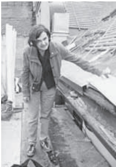
Architektin Heike Schuhbauer zeigt die zusätzlich geschaffenen Brutplätze für Mauersegler an der Herrmann-Frieb-Realschule Foto: Sylvia Weber
