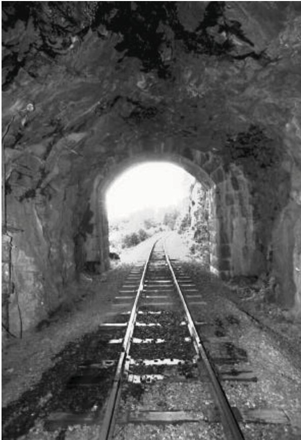
Brobackatunnelns södra mynning.
