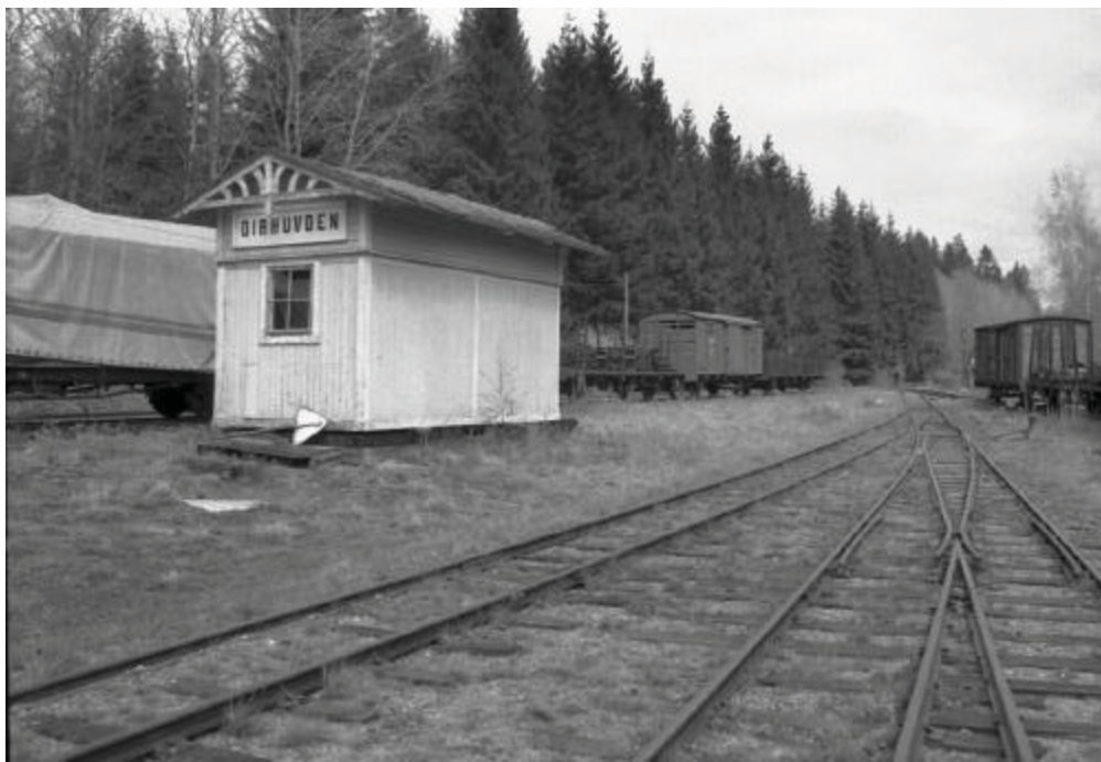
Del av Dirhuvdens uppställningsbangård med den ditflyttade hållplatskuren.
