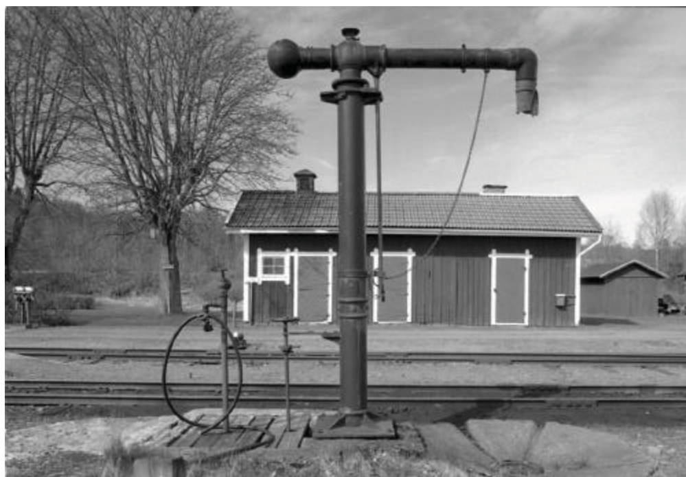
Vattenpåfyllningen (5) med uthuset (2) i bakgrunden och garaget (6) till vänster. Mot öster.
