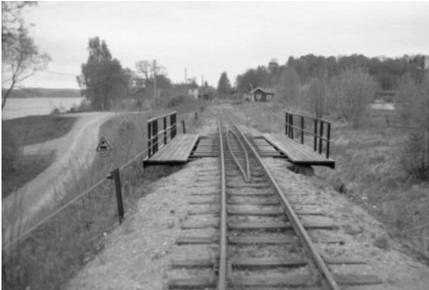
Bron ca 200 norr om Kvarnabo station, som skymtar i bakgrunden.
