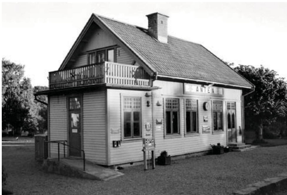
Stationshuset mot nordväst.
