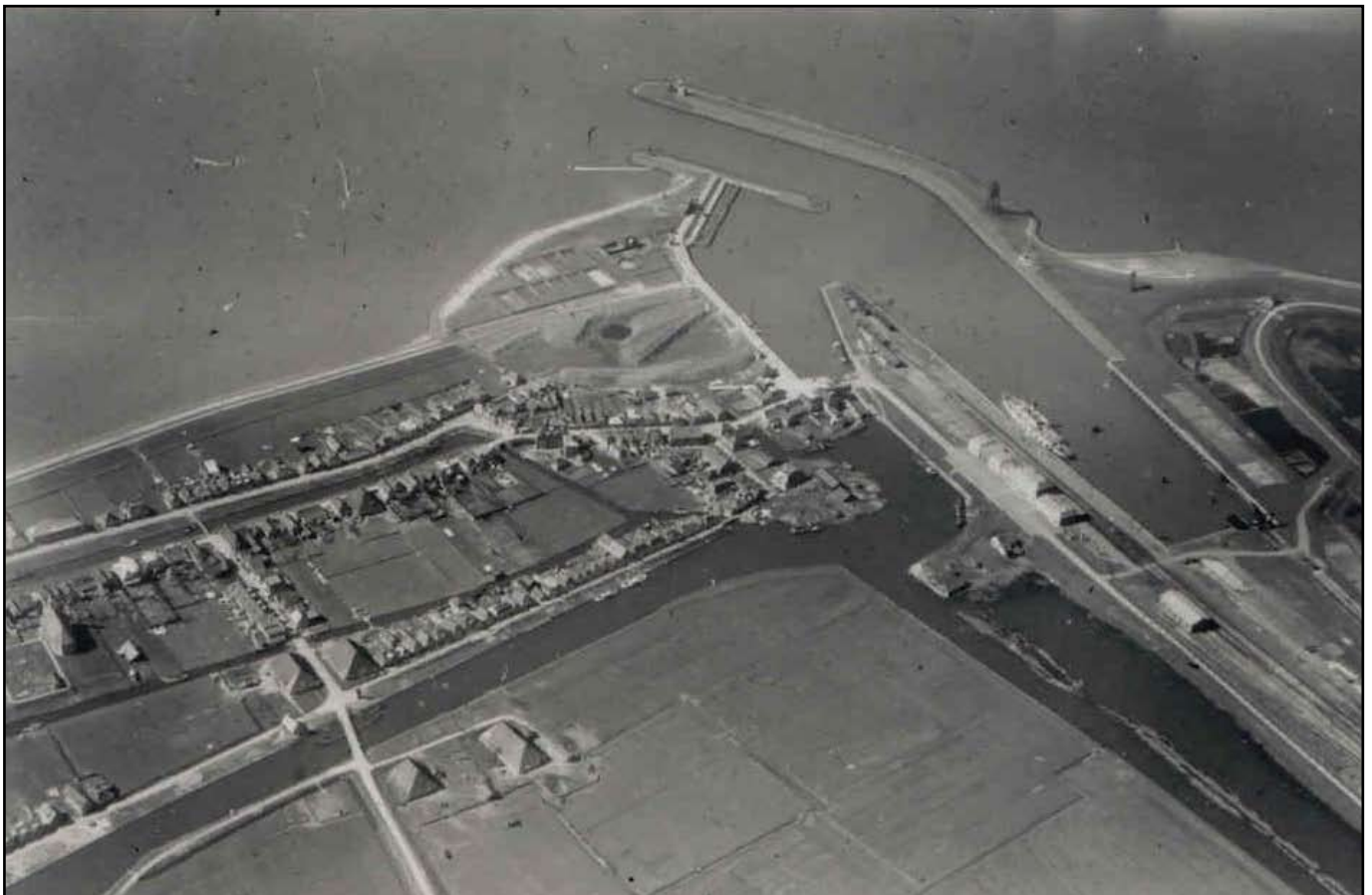
Afbeelding 32 Proefvakken voor aanleg van de Afsluitdijk in 1922 (foto: KLM Aerocarte)
