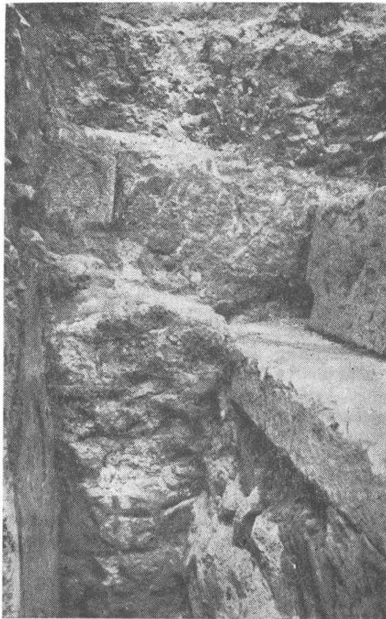
Fig. 35. — Fundația turnului T2 cu detaliu al punctului unde se alipește zidul de incintă.
