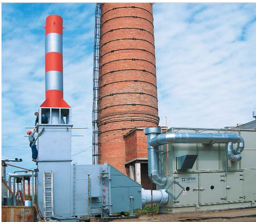
🔧 Монтажные работы на котле-утилизаторе в Вологде
