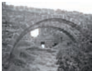
Els arcs de diafragma que sostenien el paviment de la gran sala noble del castell d'Eramprunyà. Foto: J. Campmany.
