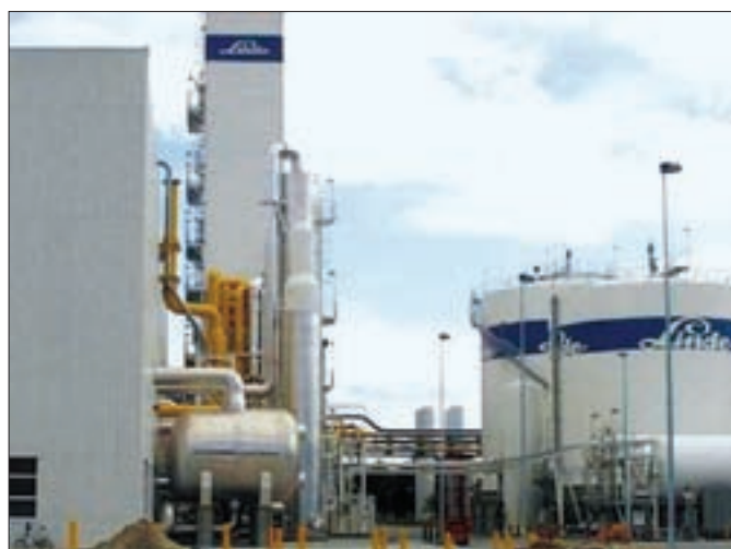
2. kép: Levegőbontó berendezés Dunaújvárosban
