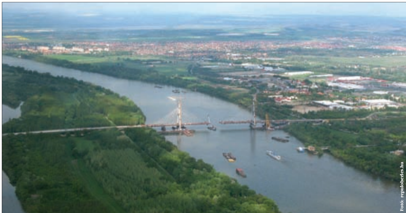
A híd három szakasza (szigeti ártéri híd, Duna-főági híd és bal parti ártéri híd)
