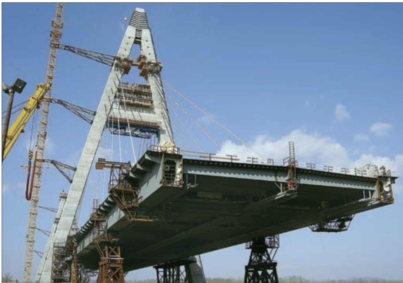
20. ábra: A merevítőtartó szerelése a bal parti hídfő felől szemlélve
