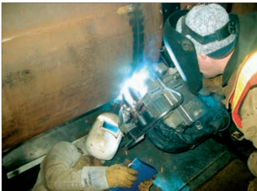
8. ábra: Négy órától 20 percre csökkent a hegesztési ciklusidő – gáz távvezeték hegesztése
