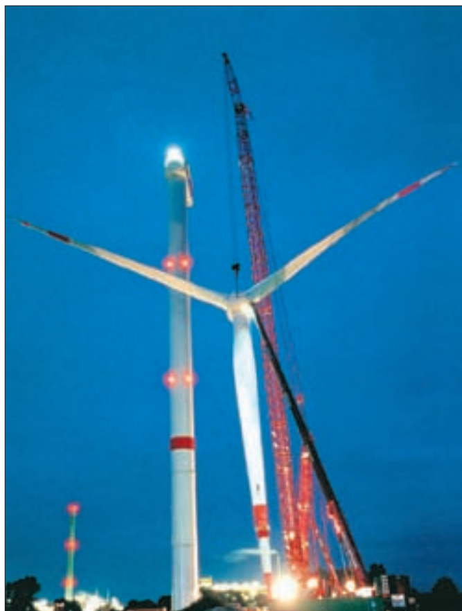
10. ábra: A rotor emelése
