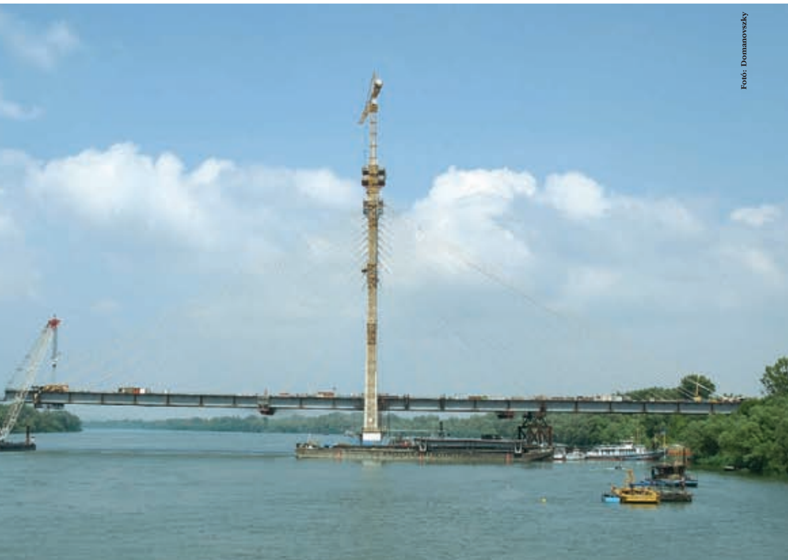
Az épülő ferdekábeles híd a sziget felől szemlélve
