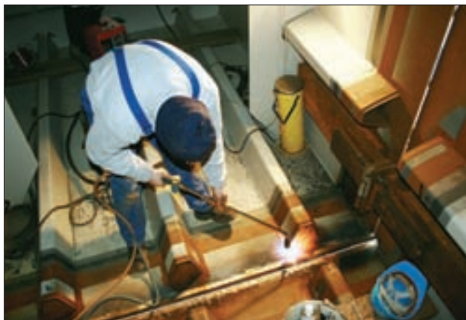
15. ábra: Előmelegítés a helyszínen
