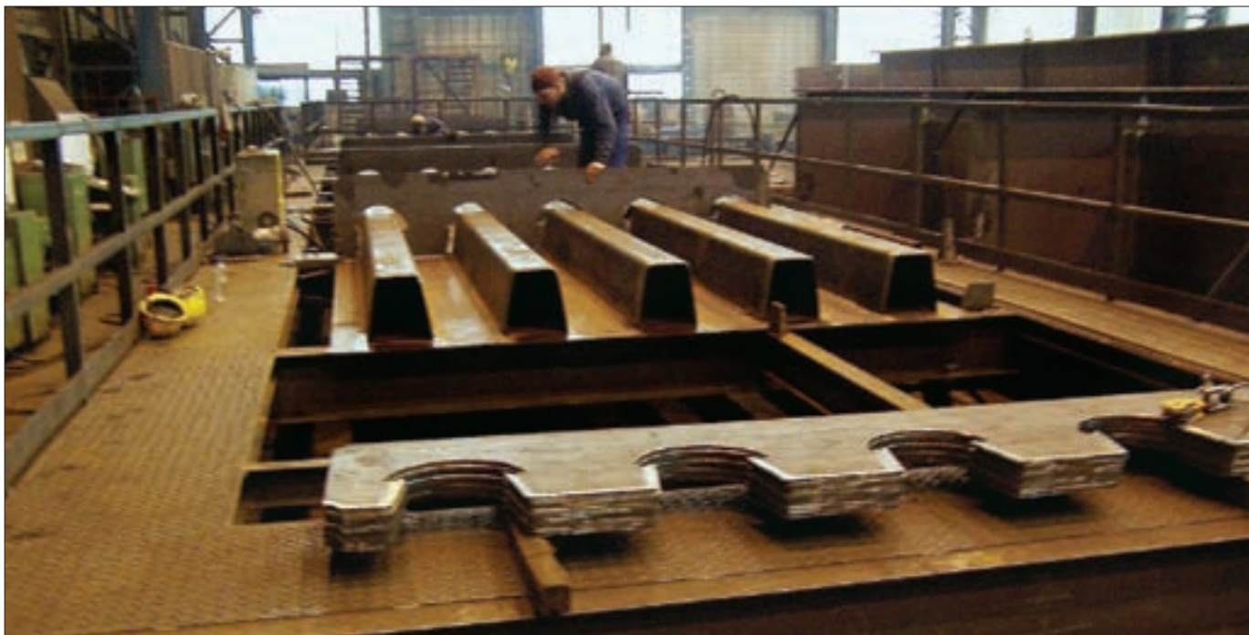
7. ábra: A kereszttartók ráépítése a pályapanelre
