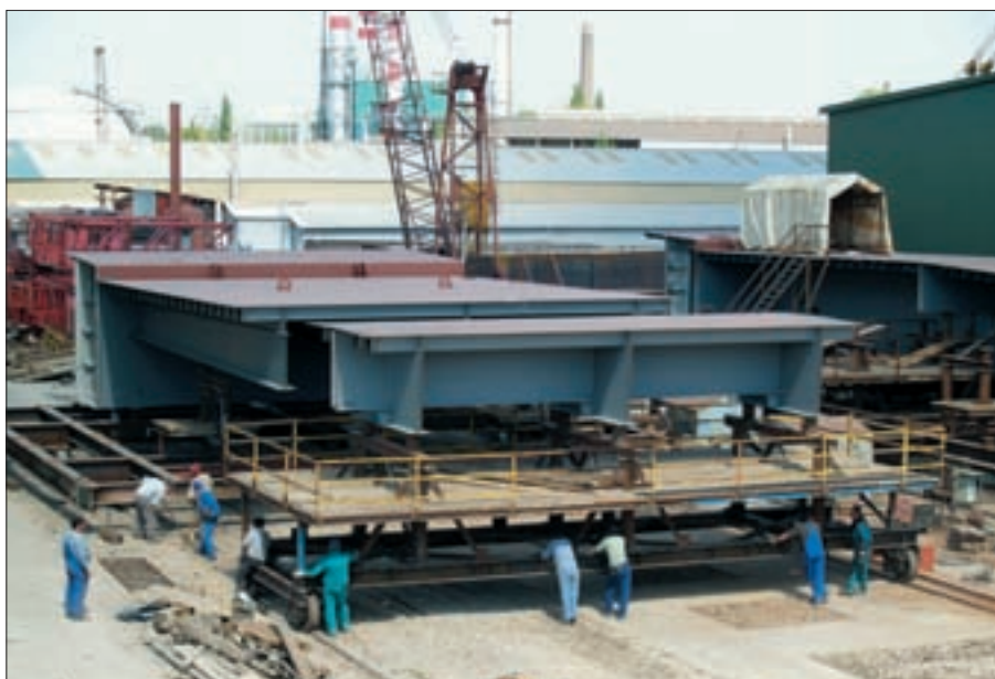
12. ábra: A merevítőtartó gyártási egységeinek összeállítása a csepeli előszerelő telepen
