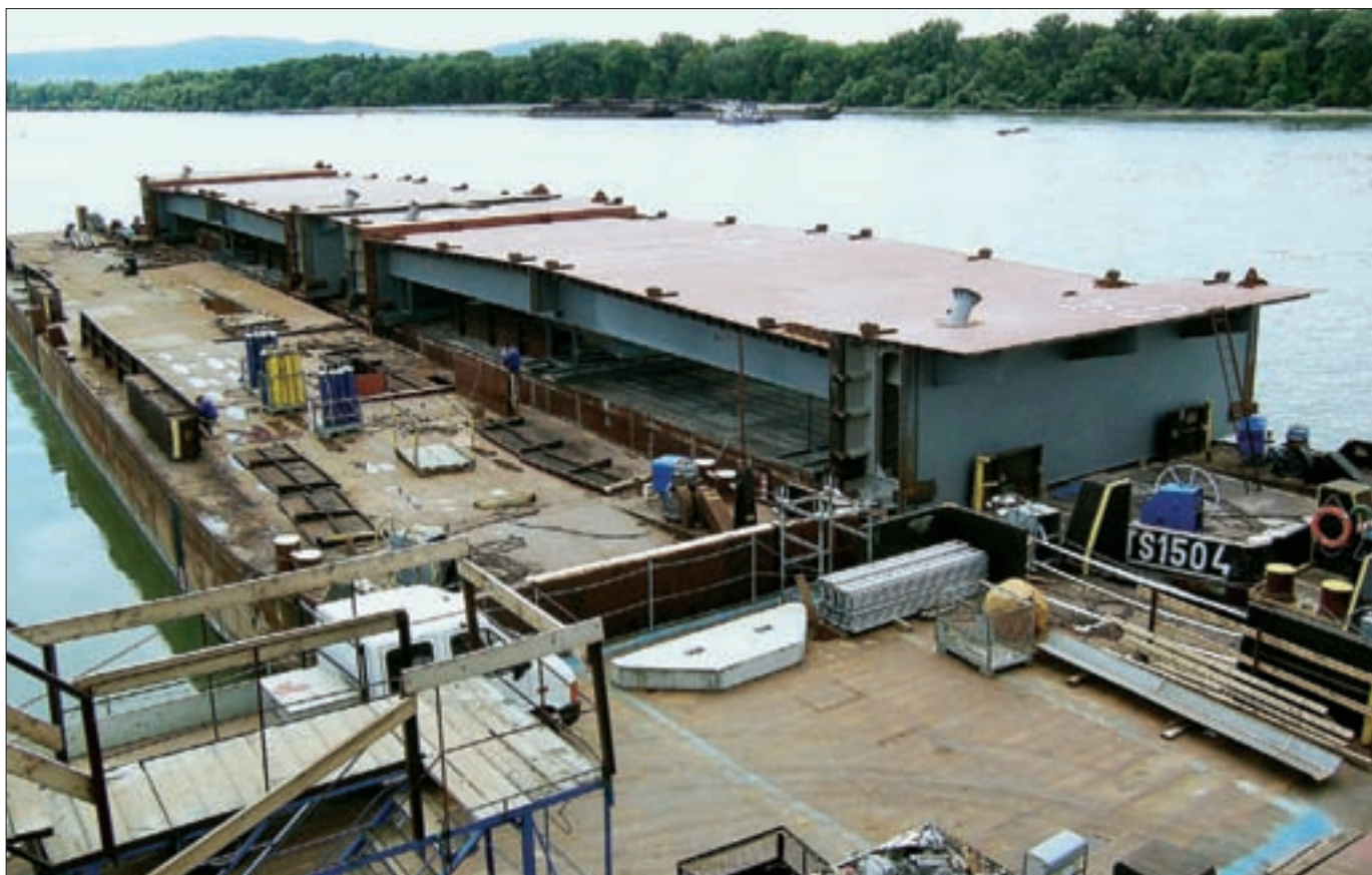
18. ábra: Két beemelésre váró pályaszerkezeti egység helyszíni tárolása bárkán
