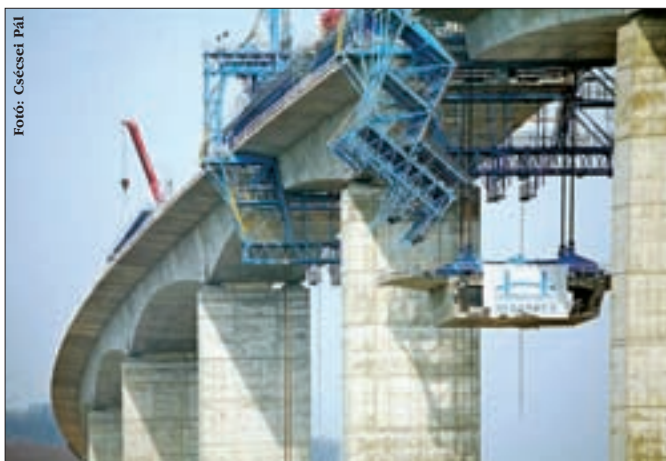
2. ábra: Épül a Kőröshegyi völgyhíd. Olcsó munkaerő, olcsó kavics?
