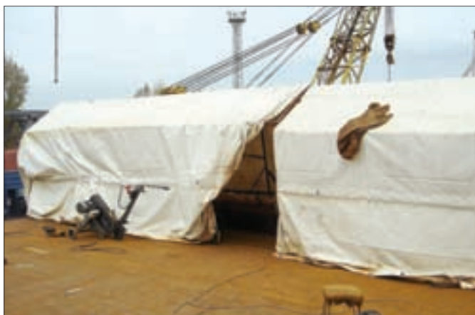
14. ábra: A szereléseknél alkalmazott védősátor
