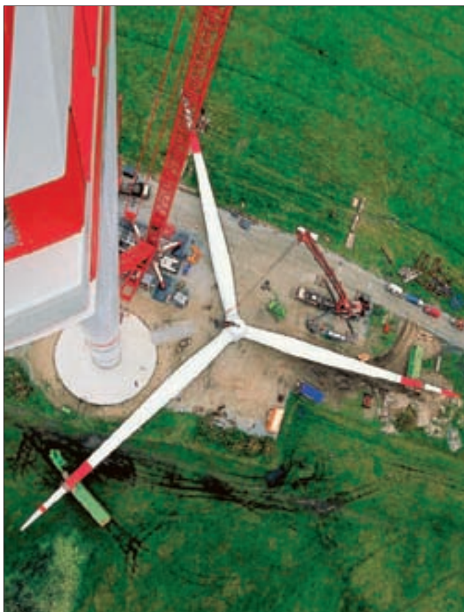
9. ábra: A földön összeszerelt rotor
