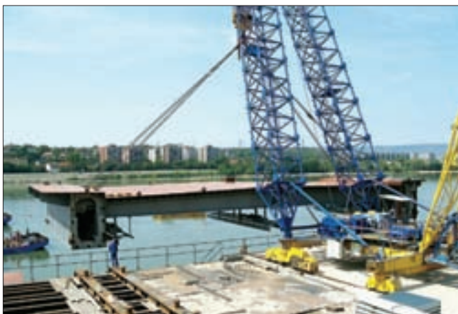
17. ábra: Előszerelt egység bárkákra emelése
