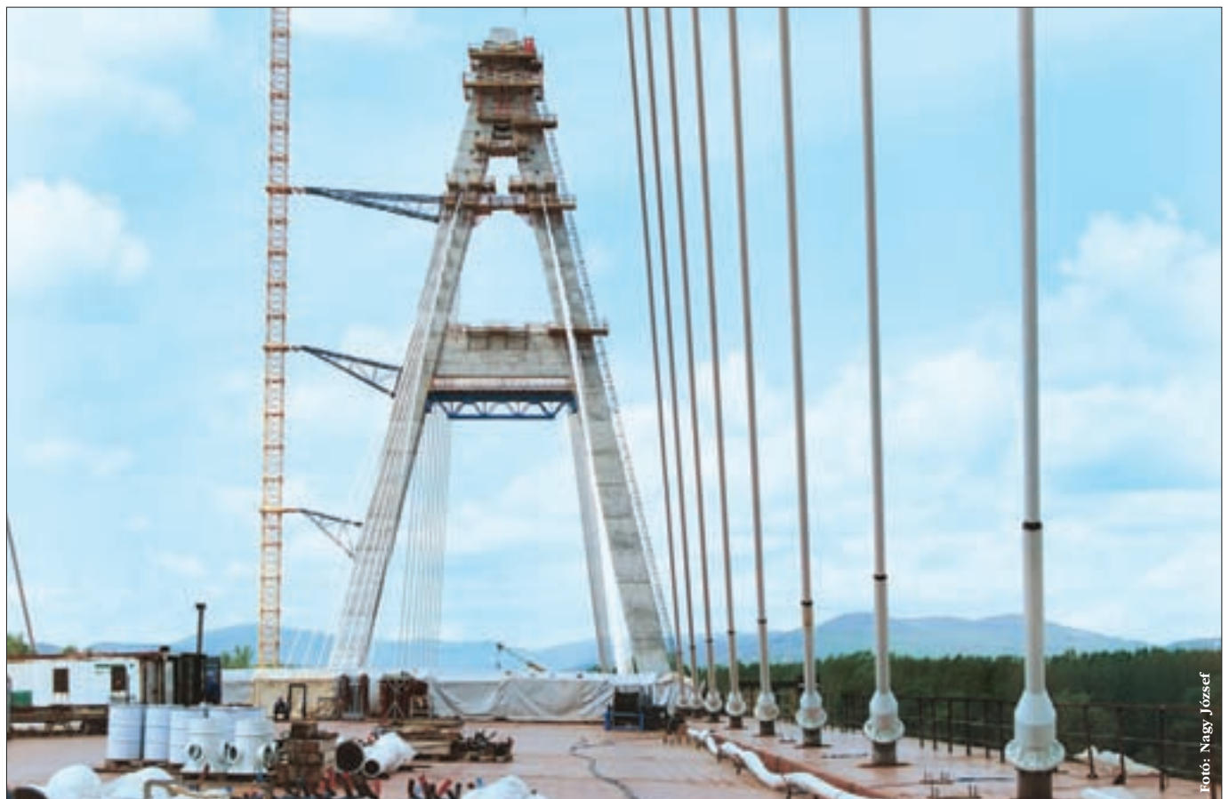
A szigeti oldali pilon és a merevítőtartó részlete a kábelbekötésekkel
