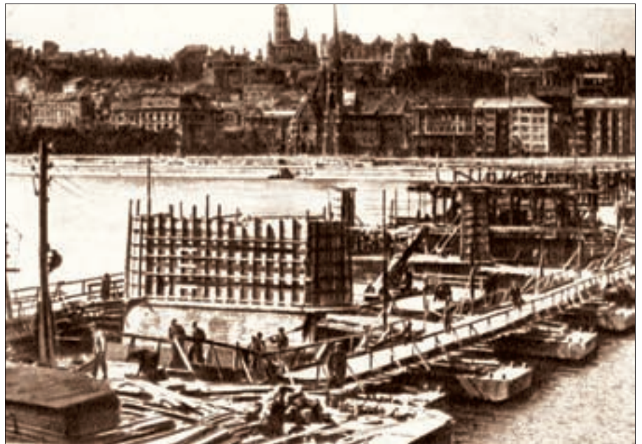
5. ábra: Pillérépítés, 1945. december
