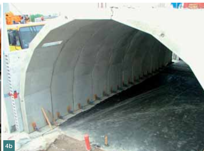
Obr. 5 Atypické ocelové kotvy zajišťující přesnou polohu stěnových dílců ■ Fig. 5 Atypical steel anchors securing a precise position of the wall panels
