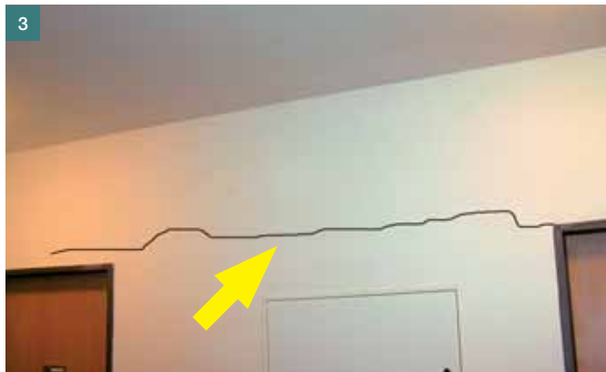
Obr. 1 Charakteristické trhliny ve stěně z vápenopískových bloků u lázeňského bytového domu ■ Fig. 1 Characteristic cracks in the wall made of lime-sand units used in a bath and residential house
