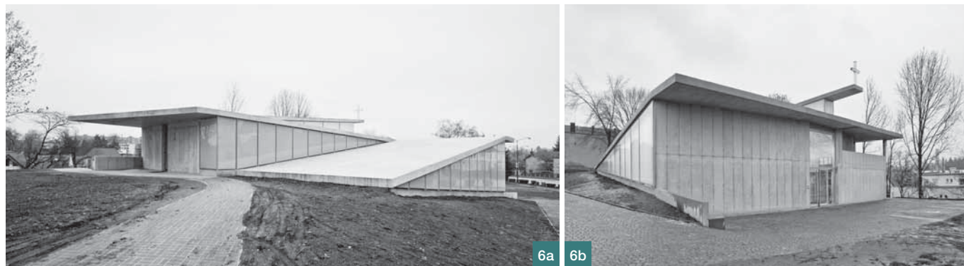
Obr. 6 Pohledy na fasády, a) pohled na kostel od západu, b) východní fasáda se vstupem do kostela ■ Fig. 6 Views of the facades, a) West view of the church, b) East facade with the entrance to the church
