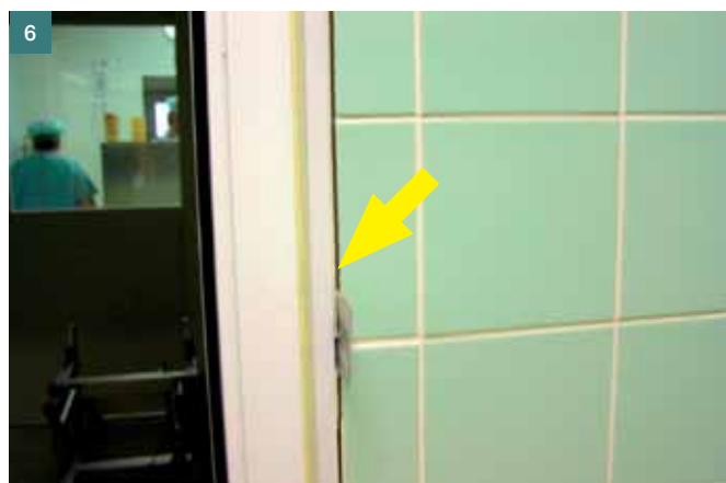
Obr. 5 Trhlina ve stěně v místě obráceného stropního průvlaků ■ Fig. 5 Crack in the wall in the location of reversed floor girder
