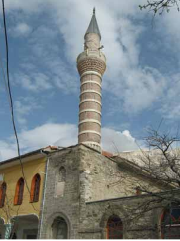
Lev 138 - Dış Cephe, Genel Görünüm
