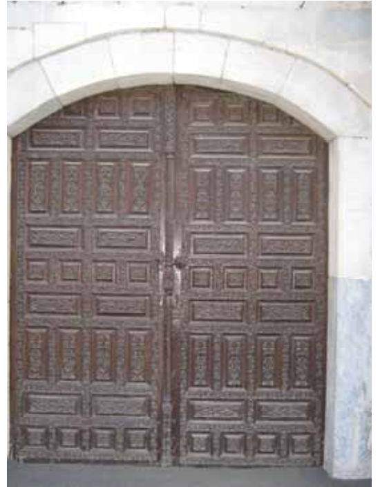
Lev.124-Kuzey Cephe, Ana Giriş Kapısı Ahşap Malzeme
