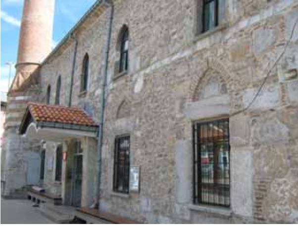
Lev.74- Kuzey Cephe, Pencere Sistemi
