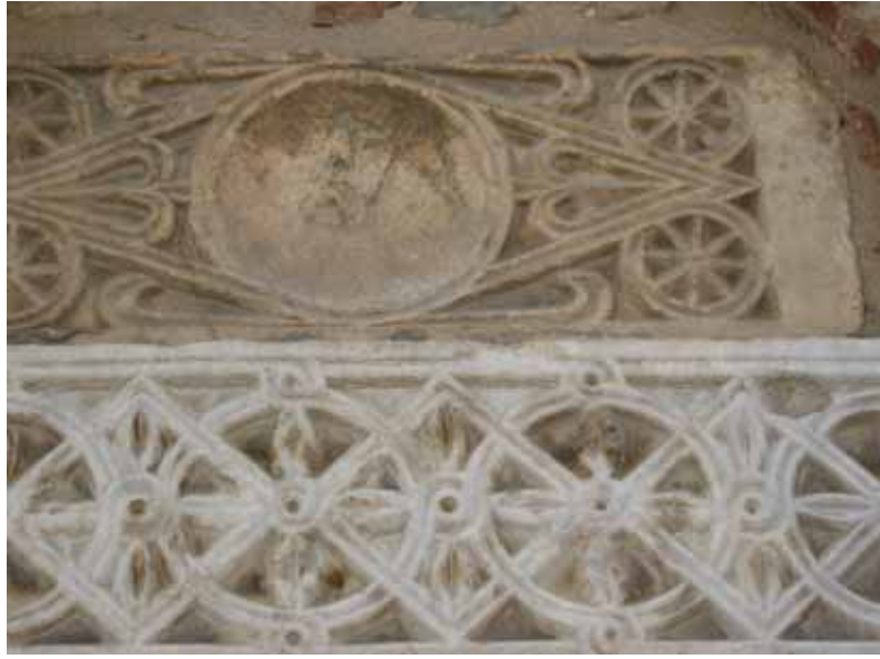
Lev.77 – Doğu Cephe, Devşirme Malzeme
