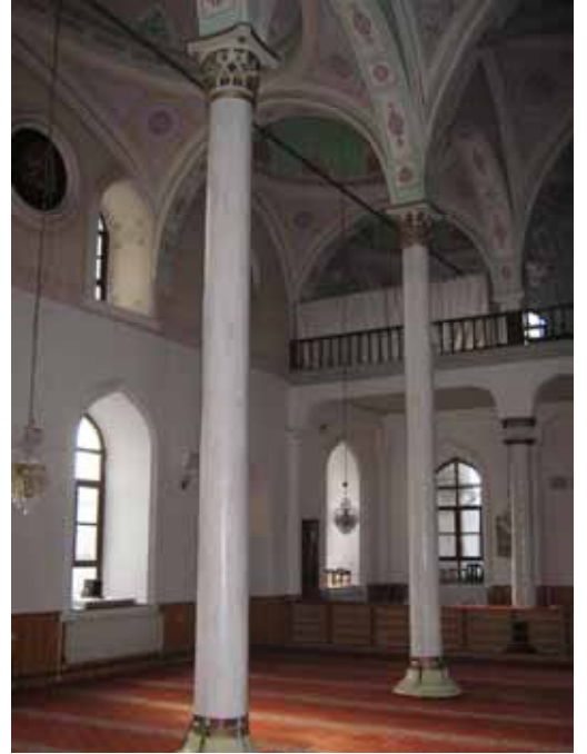
Lev.17- İç Mekan, Taşıyıcılar
