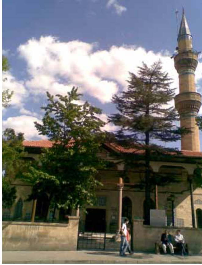
Lev.35-Kuzey Cephe, Genel Görünüm
