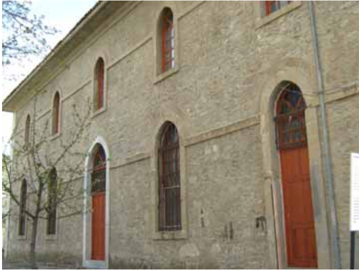
Lev. 140- Pencere Sistemi, Doğu Cephe
