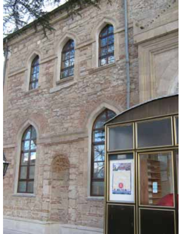
Lev.8- Kuzey Cephe, Pencere Sistemi
