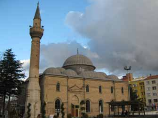
Lev.1 –Batı Cephe, Genel Görünüm
