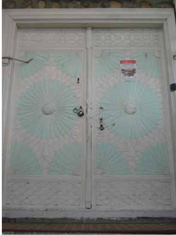
Lev.99-Kuzey Cephe, Giriş Kapısı, Ahşap Malzeme
