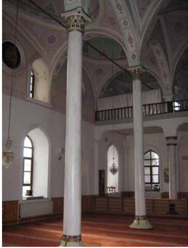
Lev.4- İç Mekan, Taşıyıcılar
