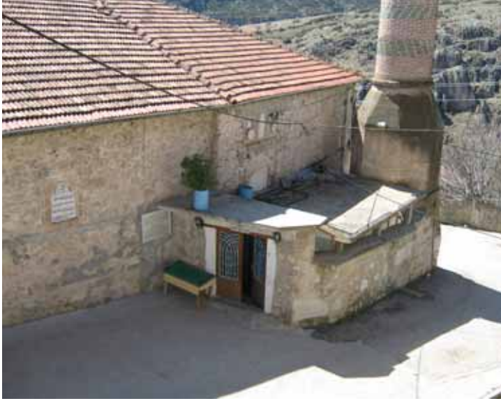
Lev.65– Kuzey Cephe, Genel Görünüm
