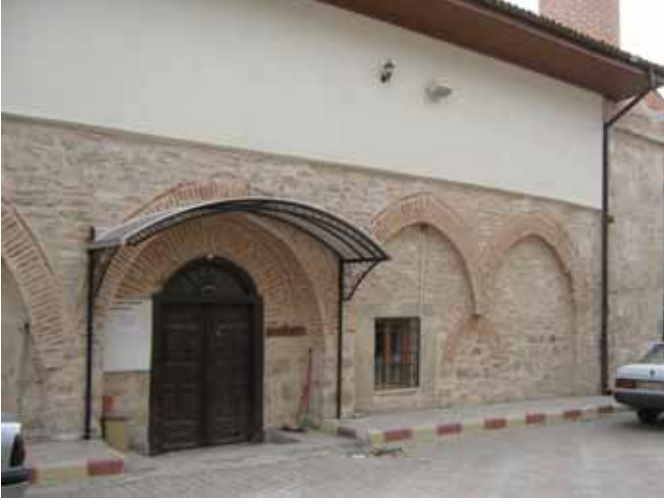
Lev.102 - Kuzey Cephe, Genel Görünüm
