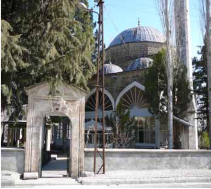
Lev.52- Kuzey Cephe, Genel Görünüm
