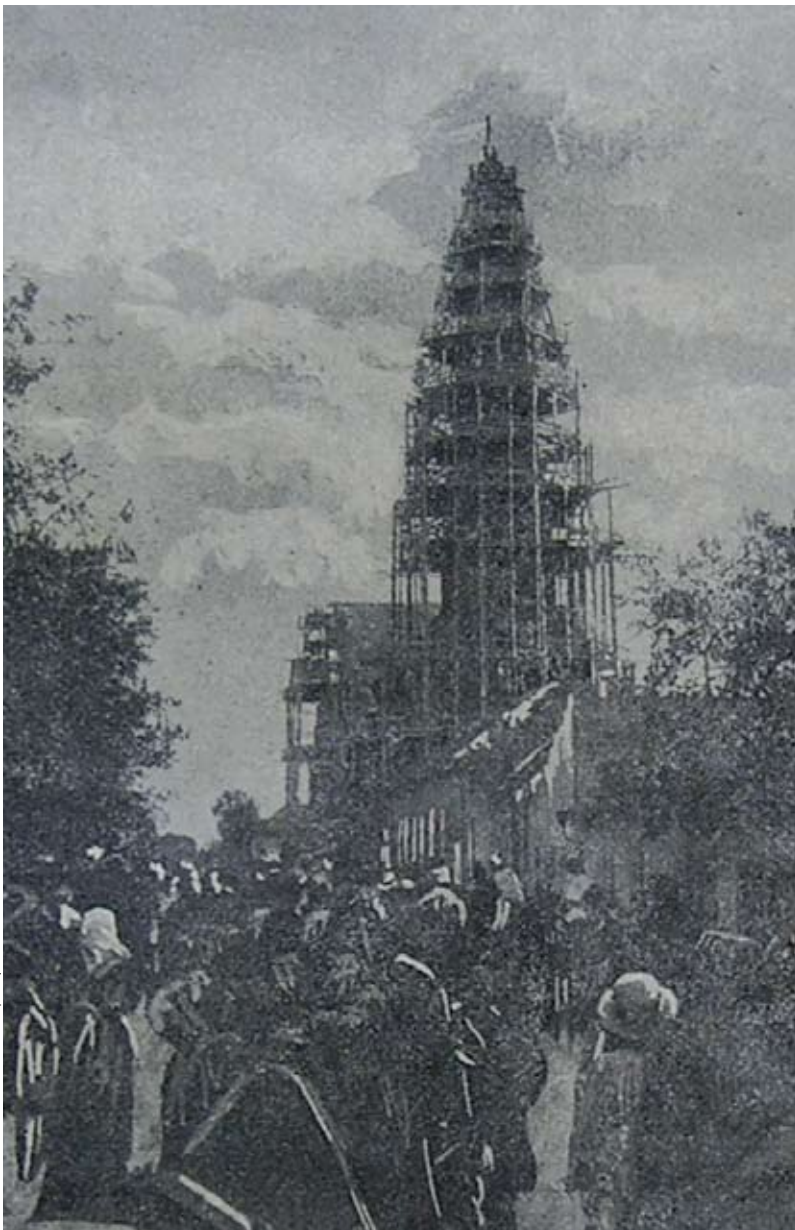
Schele pentru construcția turnului
