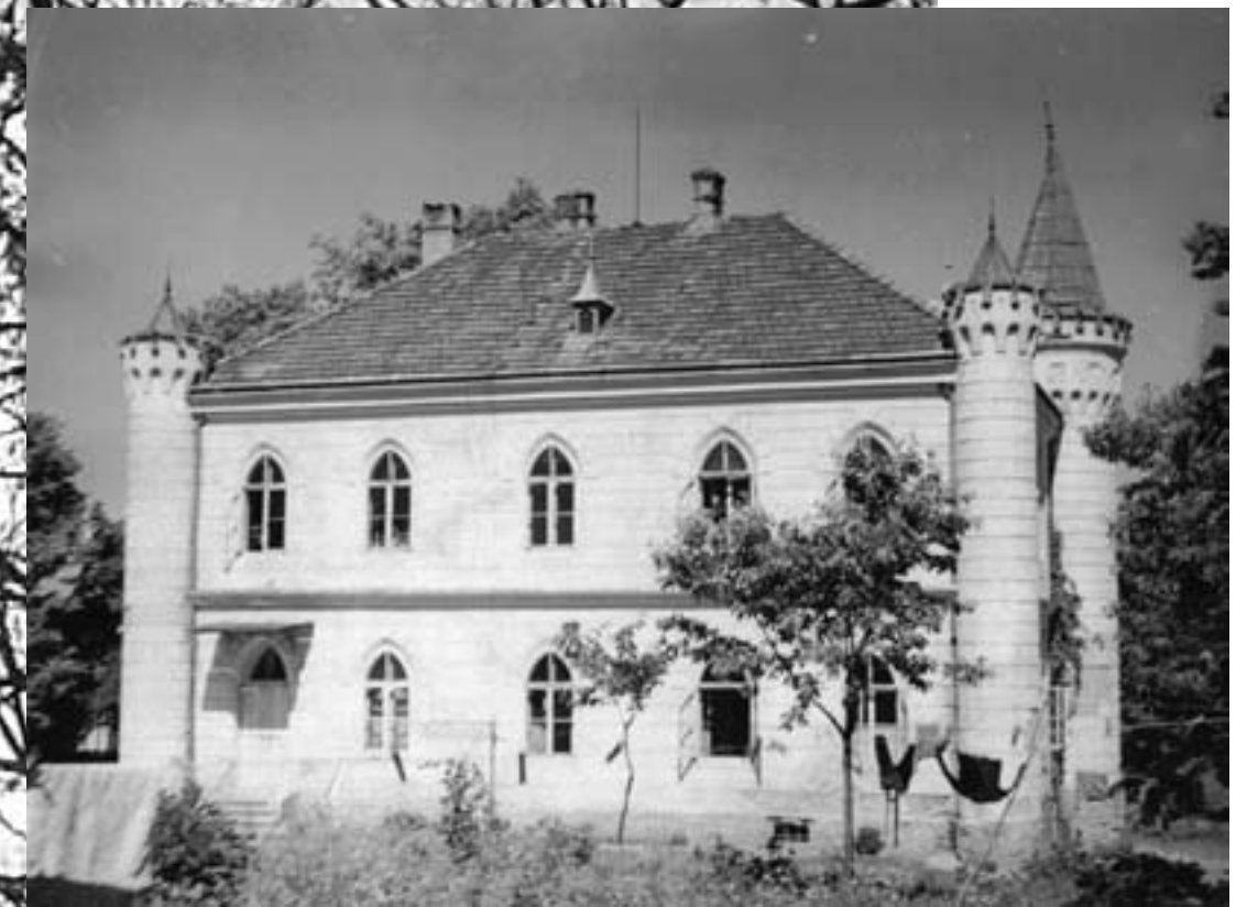
Pohľad na kaštieľ
