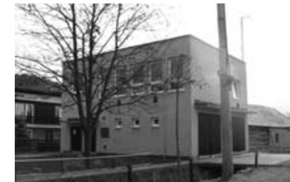
Stará budova hasičského skladišta DHZ a požiarna zbrojnica
