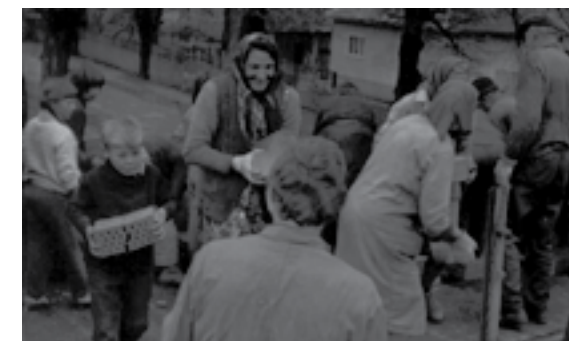
Práce na výstavbe potravín v Maršovej
