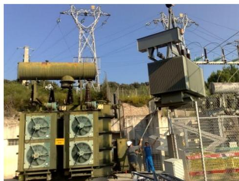
**Manutention**, démontage, préparation au transport du transformateur avant révision en atelier.
