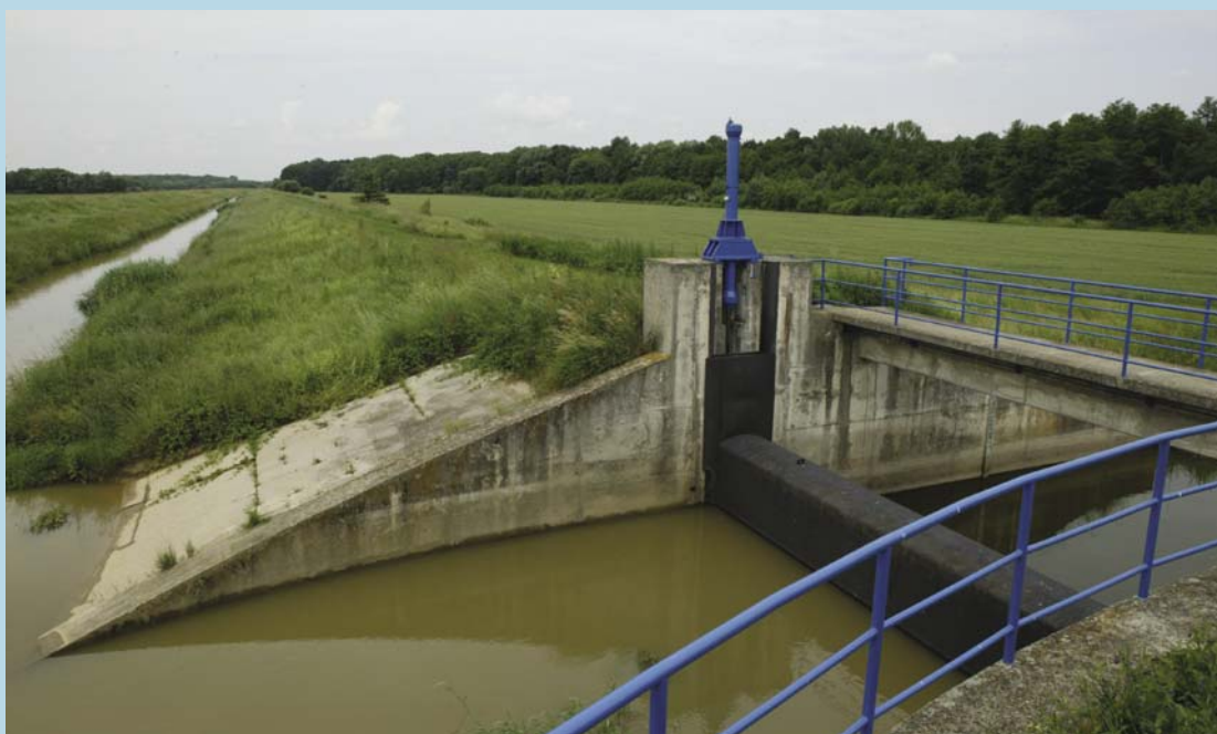
16 Zapornični objekt zadrževalnika Radmožanci Radamosi tározó vízszint szabályozó műtárgya
