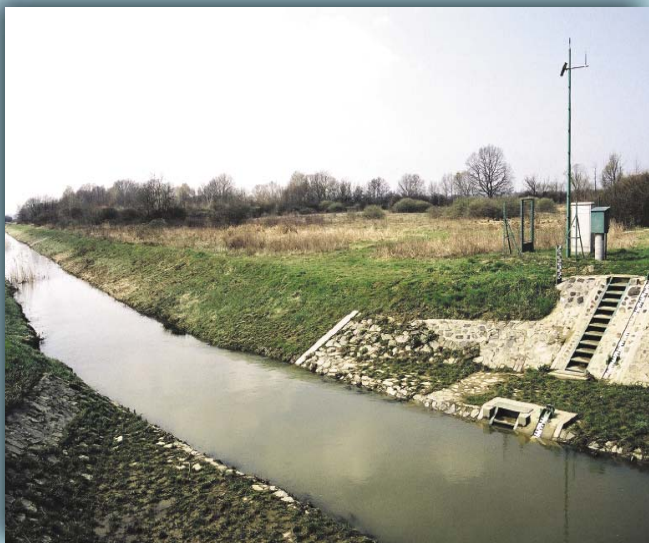
21 Vodomerne postaja na Kobiljskem potoku Vízhozam mérőszelvény a Kebele patakon
