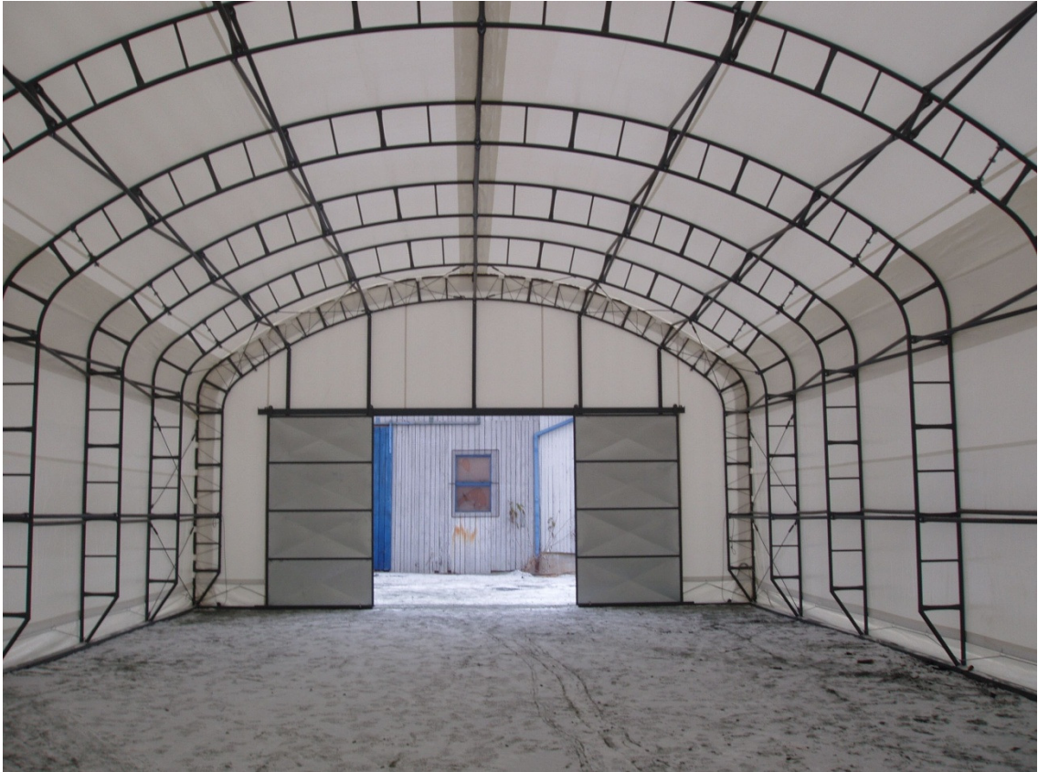
Obr. 5 Montovaná hala s ocelovou konstrukcí
