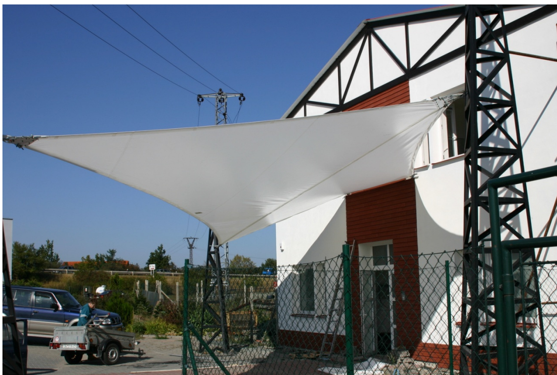
Obr. 7 Zastřešení vstupního vchodu v Modřicích
