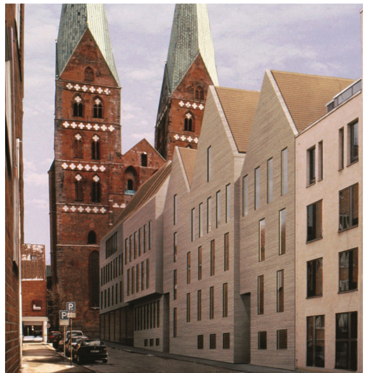
Obere Alfstraße mit dem 1. Entwurf für das im Bau befindliche „Ulrich Gabler-Haus“ (Konerding Siegmund Architekten), mit einer „Prägung aus geschichtlichem Herkommen“.
